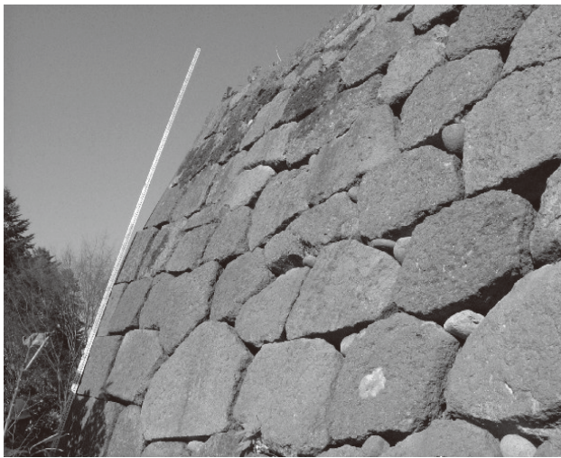
写真1-3 修築前玉泉院丸石垣 変状状況
