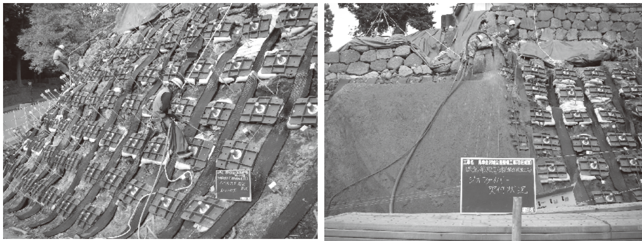
写真6-23 連続繊維補強土工 施工状況
