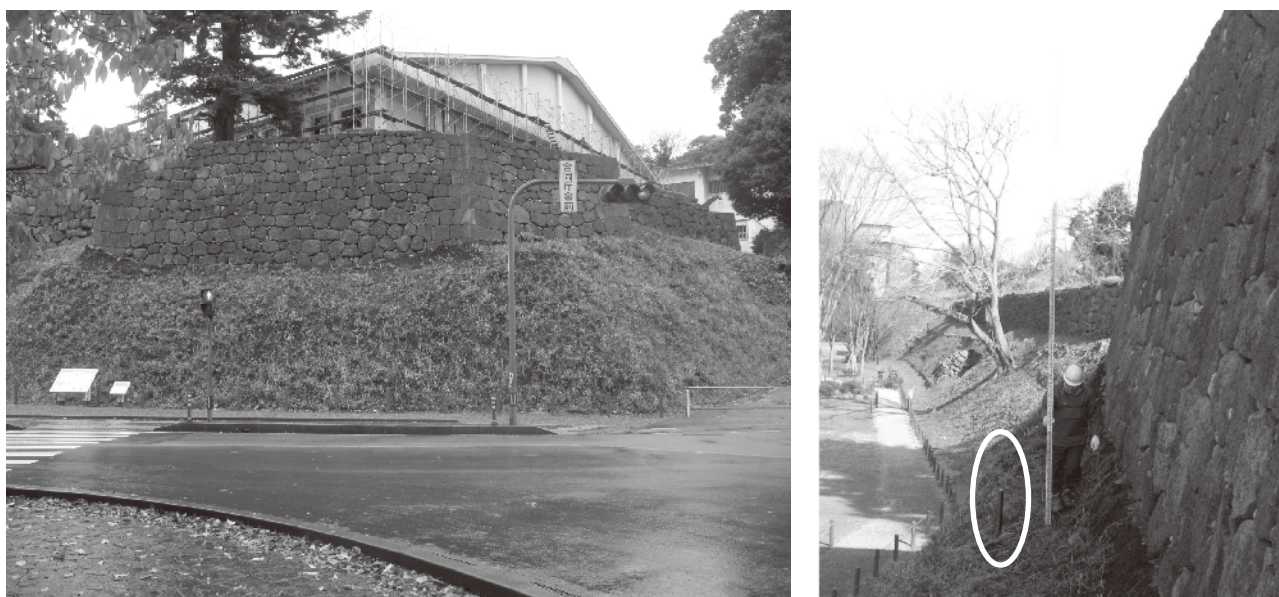
写真 6-25 修築工事完了写真及び孔内傾斜計観測パイプ
