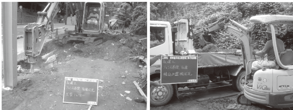
写真 6-24 防護柵等の仮設物撤去状況
