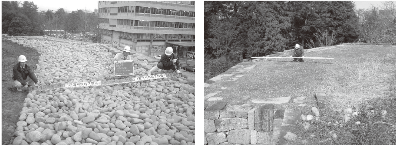
写真6-21 天盤部施工状況
