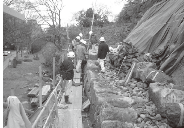
写真 6-13 丁張り設置状況
