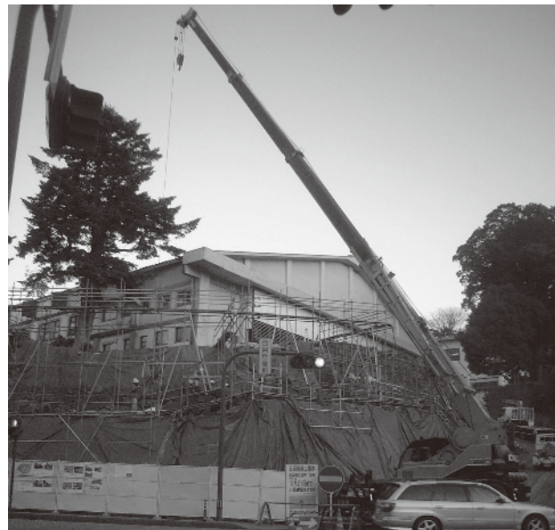
写真6-20 足場仮設状況
