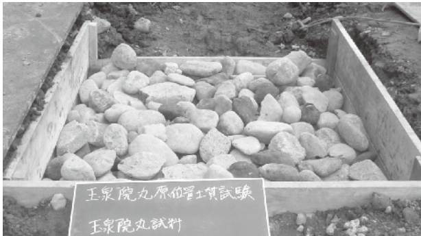
②中詰め状態 手詰めで充填
