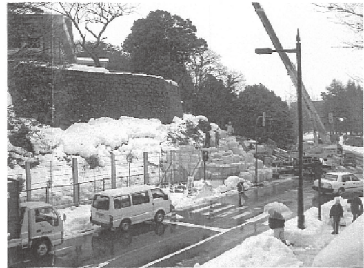
H17.12.23 大型土のう積み 着工
