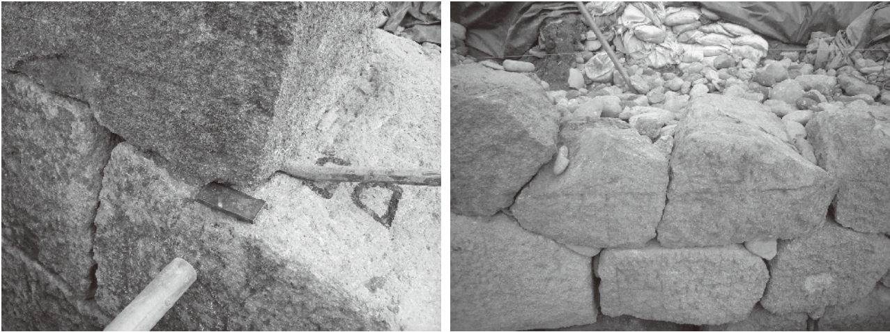
写真 6-15 詰石やプレート挿入による石材姿勢の調整
