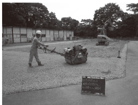
写真 6-2 石材仮置き場整備
