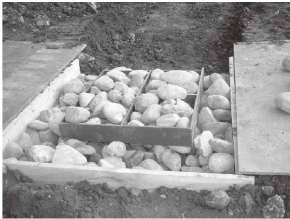
(せん断枠設置)
