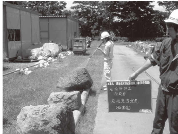
写真6-8 石材洗浄状況
