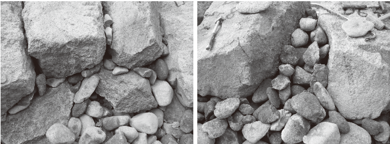
写真 6-16 詰石等による石材（築石）の固定
