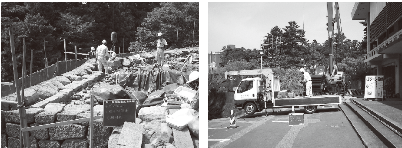
写真6-6 石材解体状況
