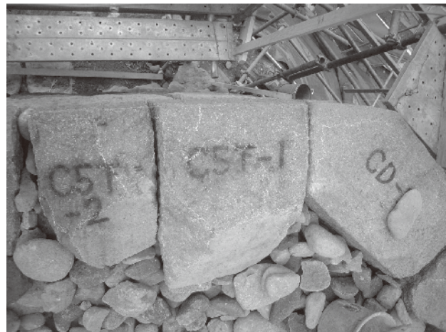
写真 6-16 詰石等による石材（築石）の固定
