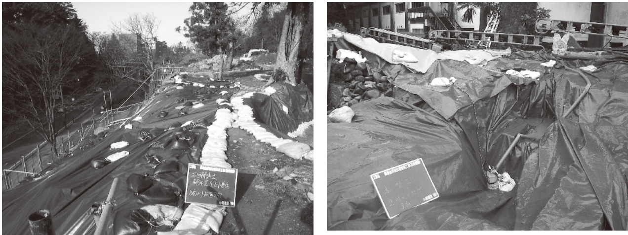
写真 6 - 9 掘削面保護・雨水処理状況
