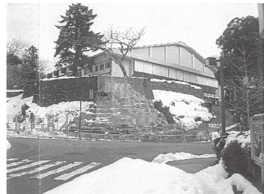
H17.12.29 保護シート、ロックネット設置完了
