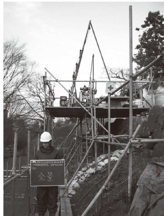
写真3-1 ボーリング実施状況
