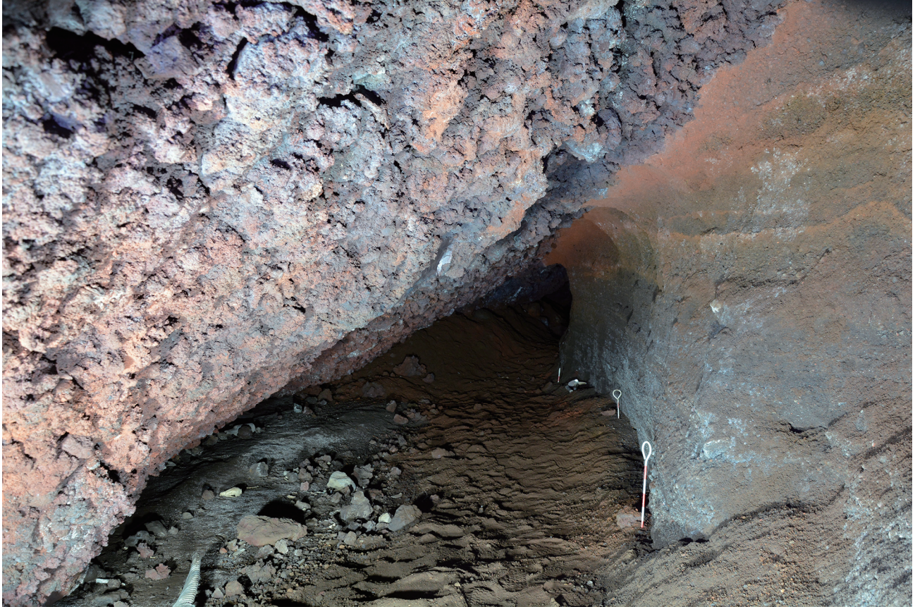
蝙蝠穴調査前現況（トレンチ 2 付近）北東から
