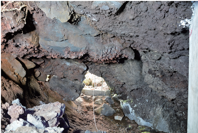
隧道内現況 (出口付近) 南から
