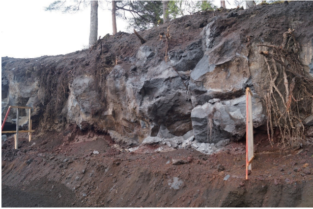
第 17 図 鐘山通り沿いに露出した鷹丸尾溶岩の断面
