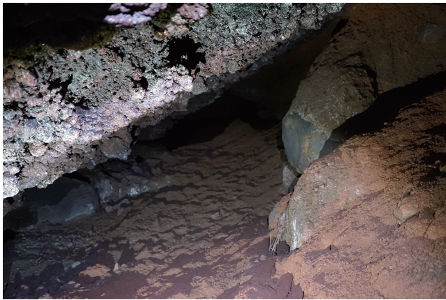
隧道内現況 (出口より 40m) 北東から
