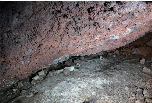
隧道内現況 (出口より 28m・表層遺物) 北から
