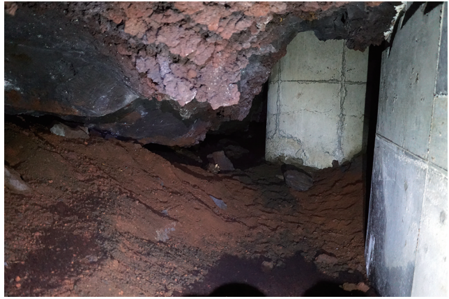
隧道内現況 (出口より 35m) 北東から
