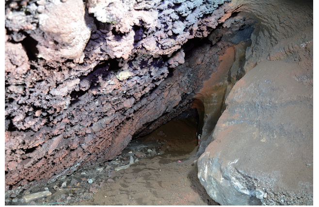
隧道内現況 (出口より 20m) 北東から
