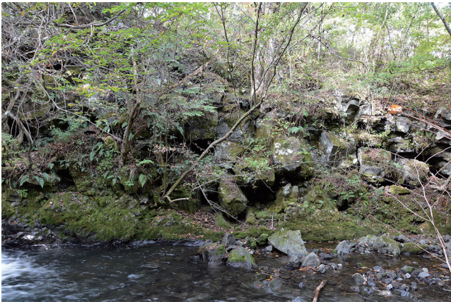
蝙蝠穴現況 (桂川取水口付近) 南から
