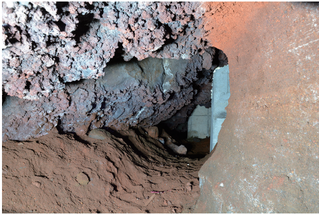
隧道内現況 (出口より 32m) 北東から
