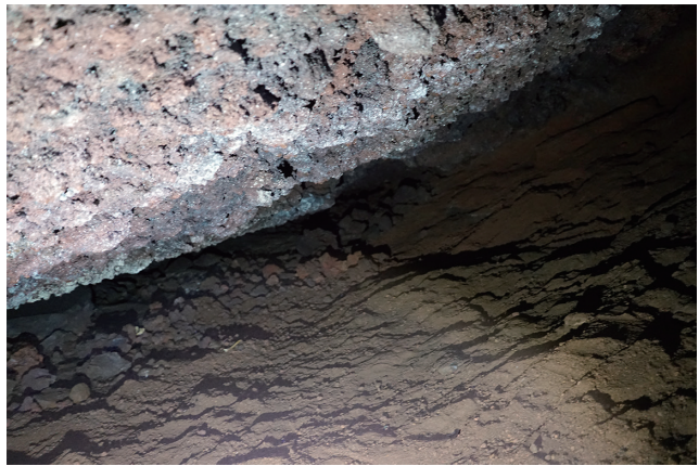
隧道内現況 (出口より 45m) 北東から
