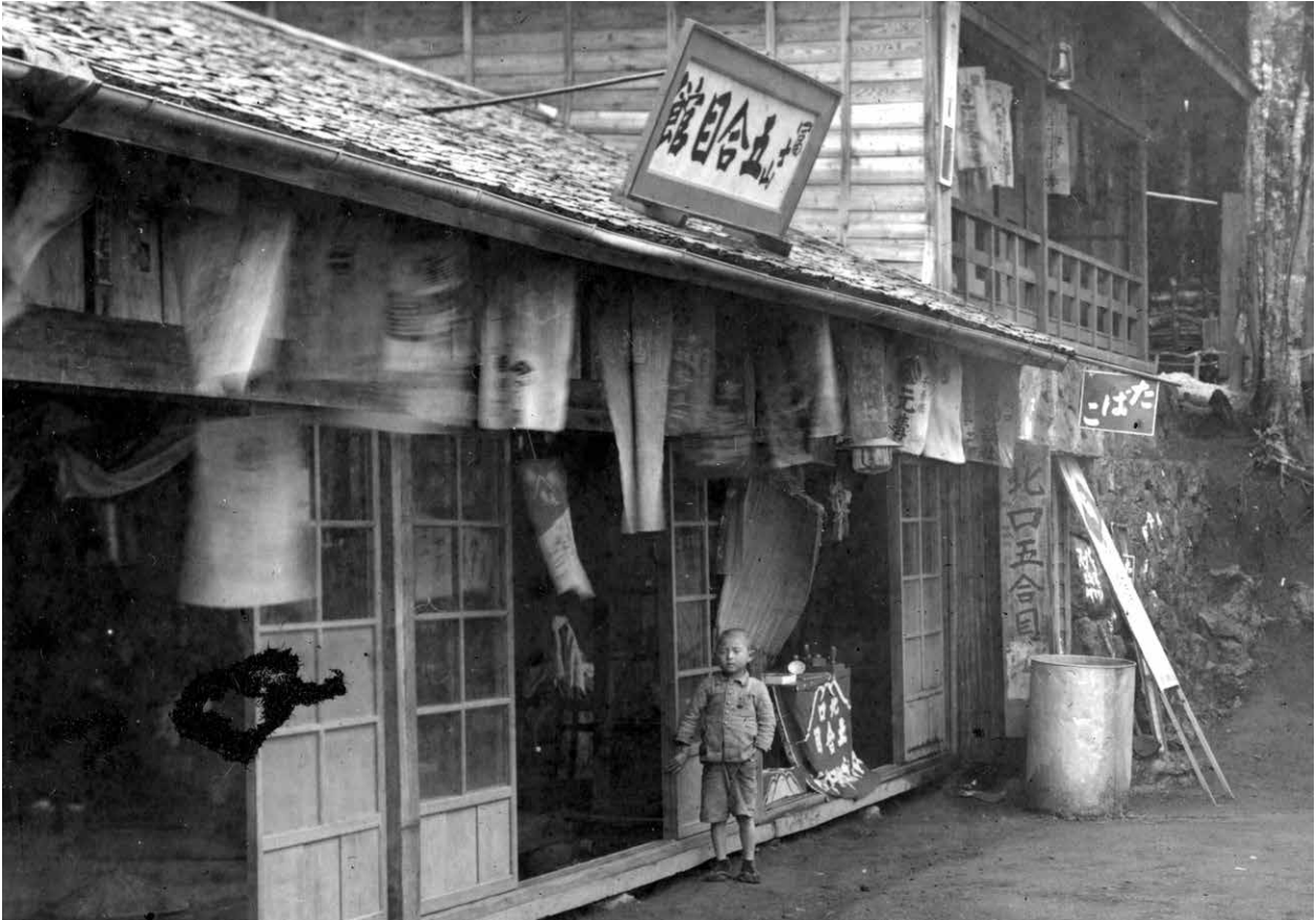
写真 2-39 五合目館の軒先の樋と水タンク（個人蔵）
