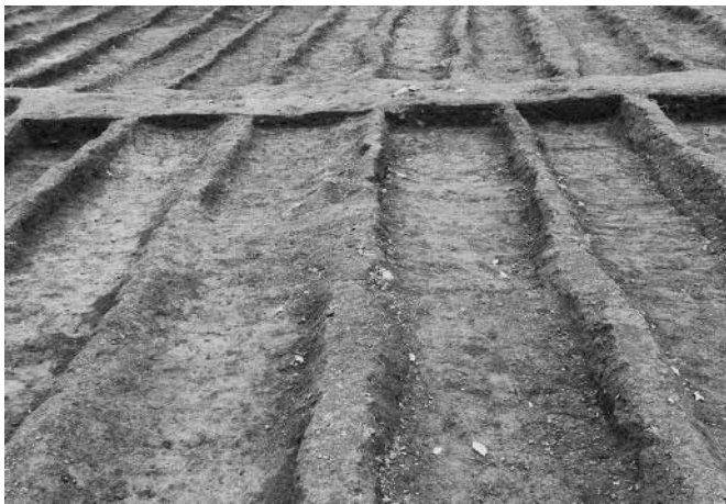
3 2号・3号復旧坑群南部 西から
