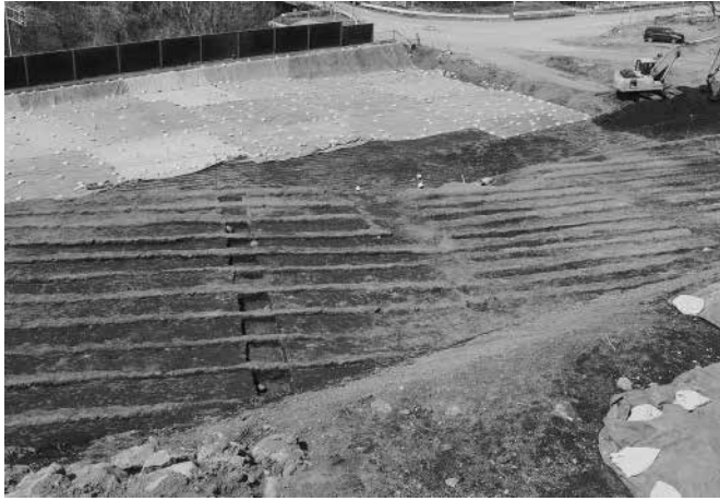
1 2号・3号復旧坑群北部 南西から
