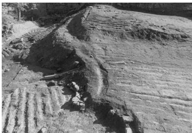
3 6号道・3号石垣 北から
