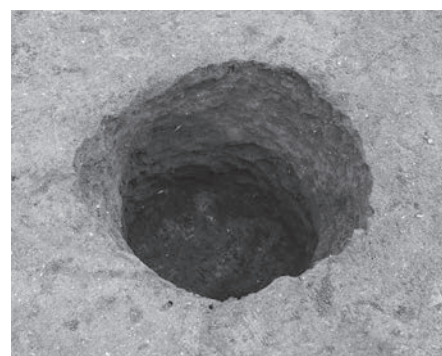
15 3区P67全景(南から)
