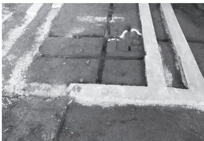
7 2区1号竖穴建物掘り方(西から)
