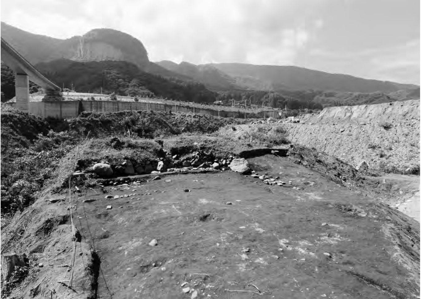
1 B区1面高台部分全景(奥に丸岩)(北東から)
