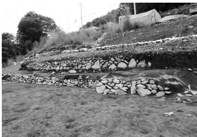
5 A区1面4号石垣全景(南東から)
