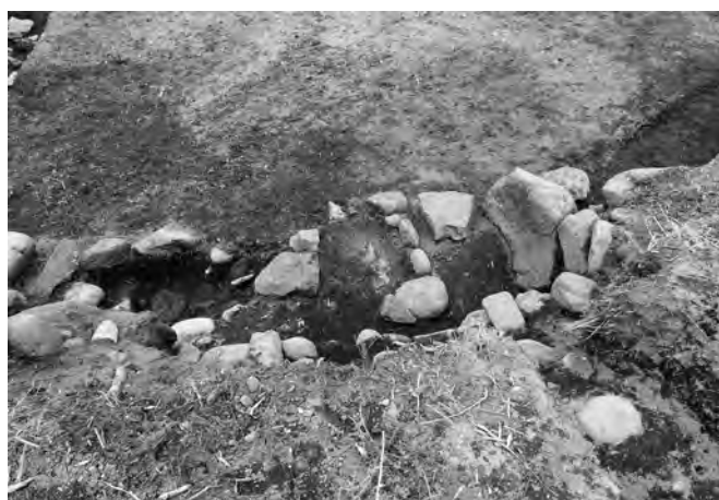
8 B区1面高台部分石垣(南東から)
