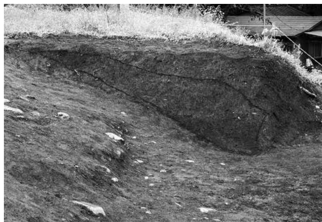
4 1区西区1面西壁土層断面B-B' (東から)
