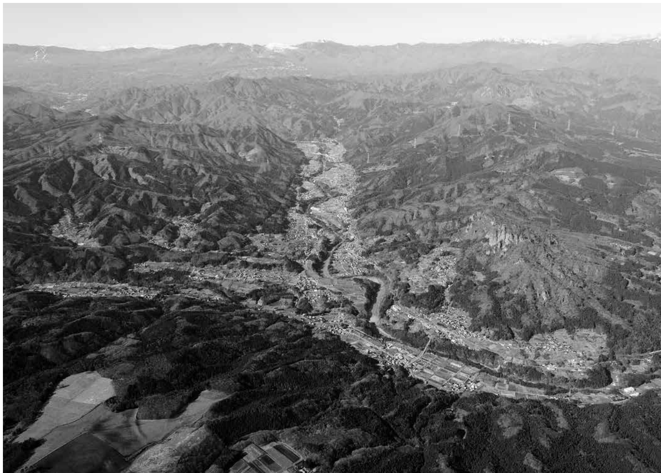
1 上信自動車道吾妻西バイパス路線域全景(南西から)
