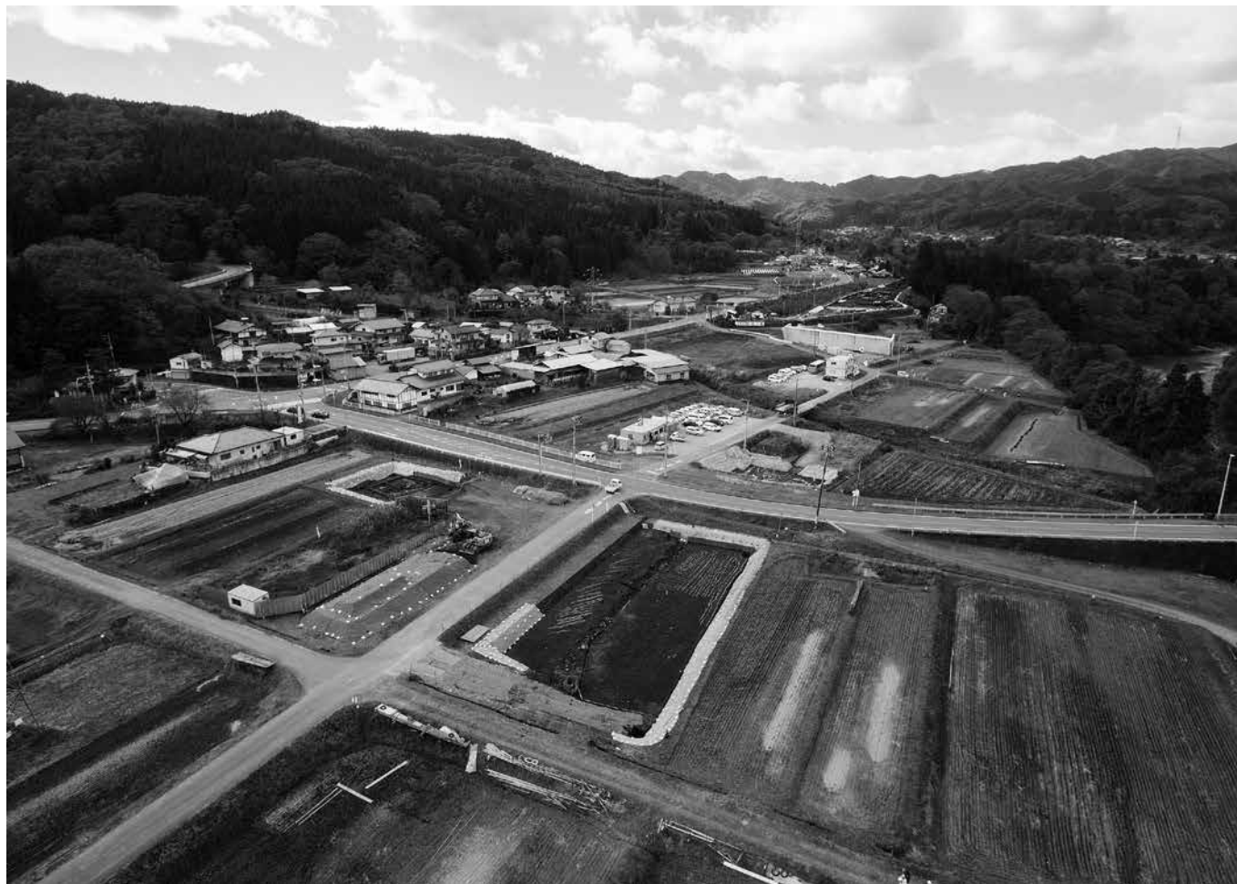
1 7～9区遠景(東から)
