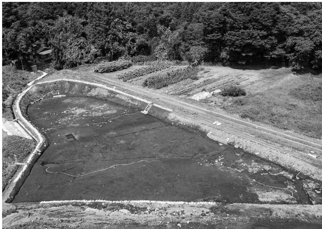
5 2区西区1面全景(南東から)
