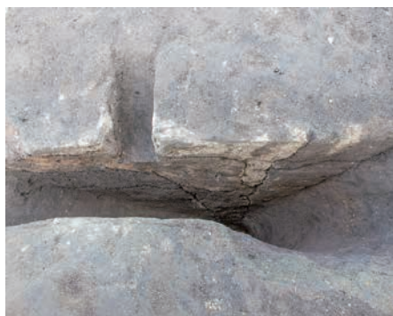
14 129号ピットセクション(南より)
