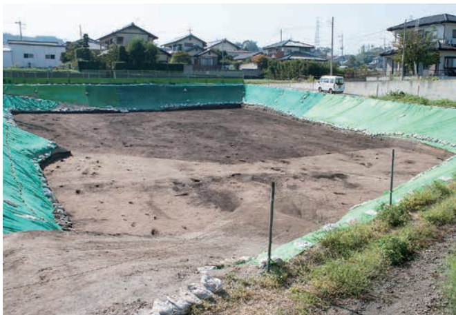
3 10区南部全景(南東より)
