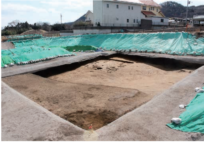
1 9区橋脚部調査状況(北東より)
