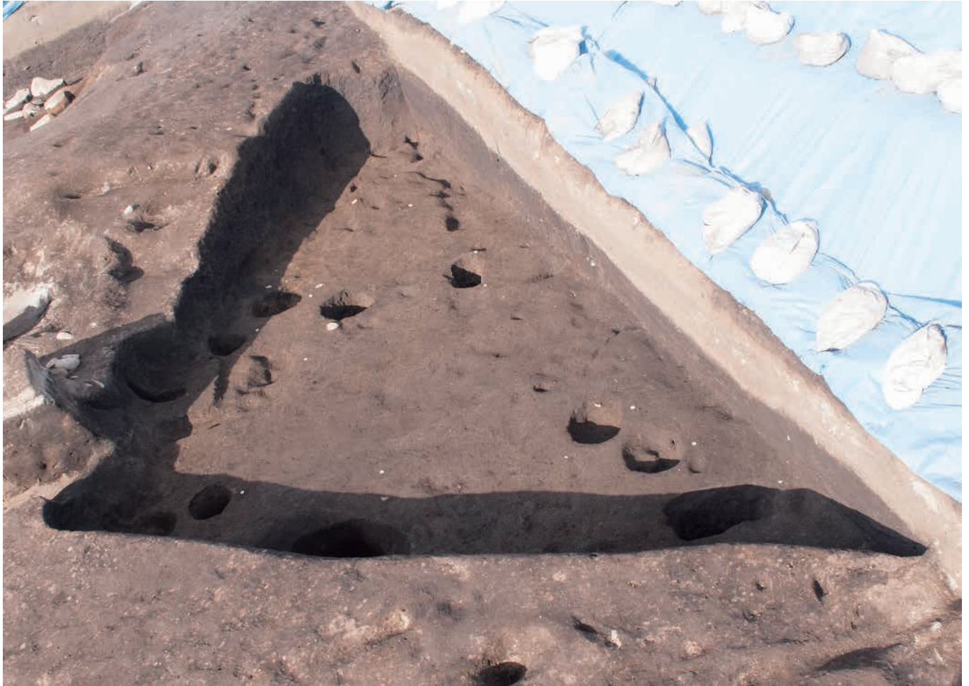
1 10号竪穴建物完掘(南より)
