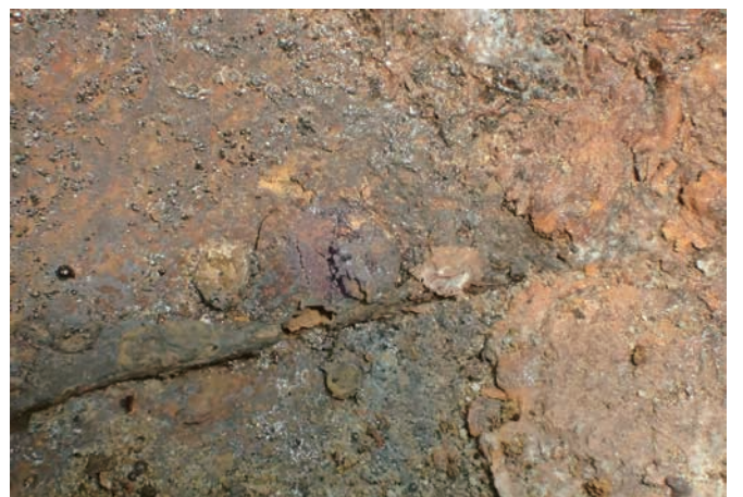
写真345 伏板と地板第1段に打たれた鉚脚
