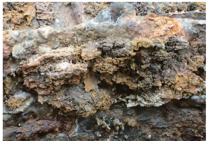
写真398 写真397の被膜痕のアップ
