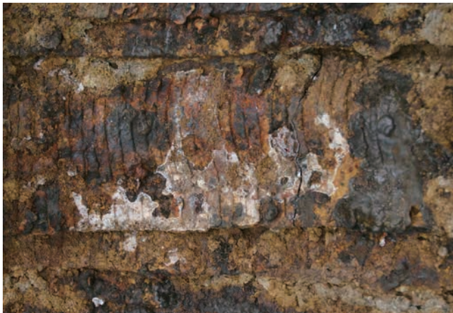
写真 130 1号甲後側内面の腰札配列状況
