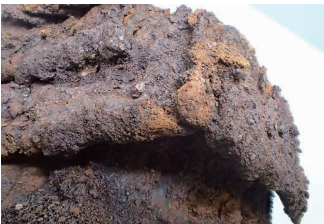
写真176 1号甲下搦み(長側第3段内面)
