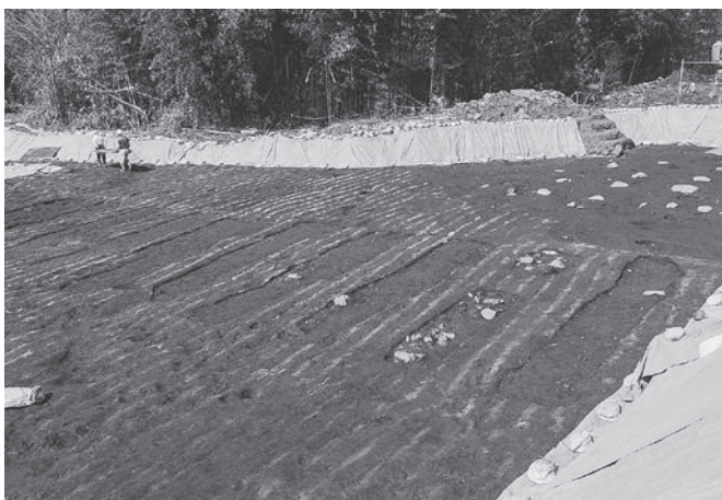
7. 復旧溝全景(北東から)
