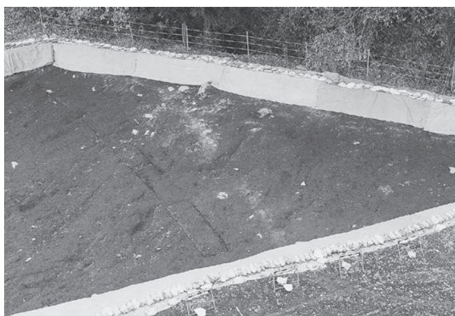
7. 1号道南部(北東から)
