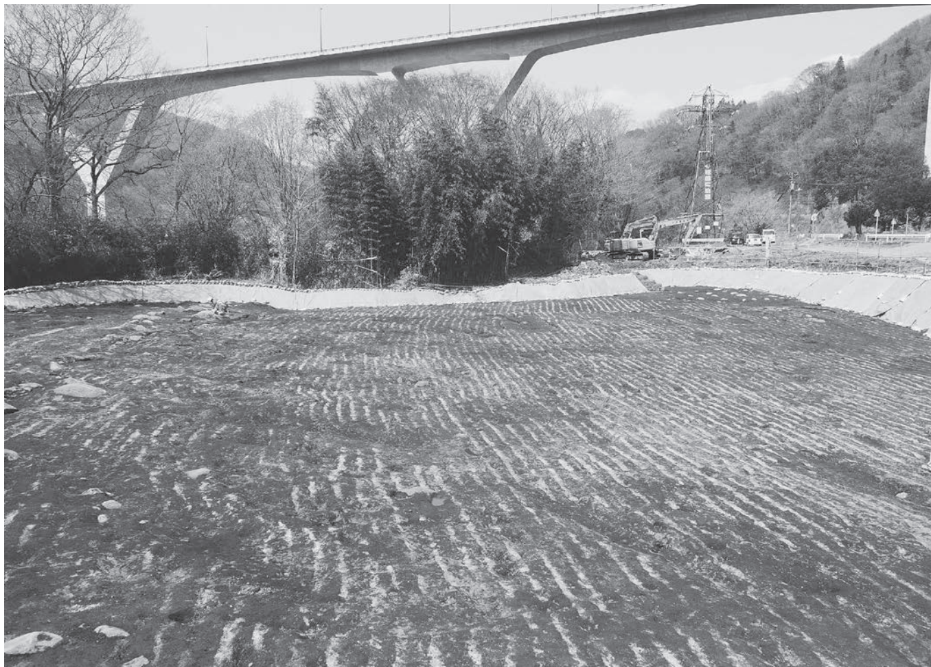
1. C区全景(東から)
