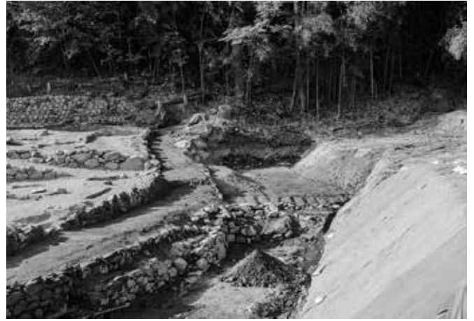
2 6号道、山の傾面に登っていく(南東から)
