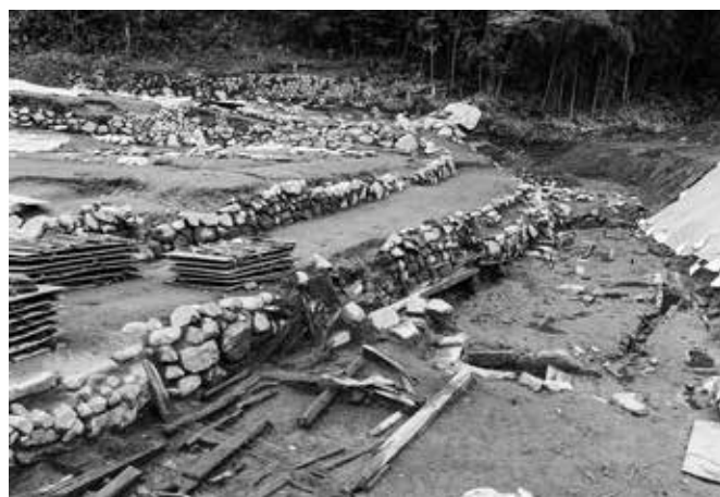
4 2号石垣、6号道段下部分(南東から)
