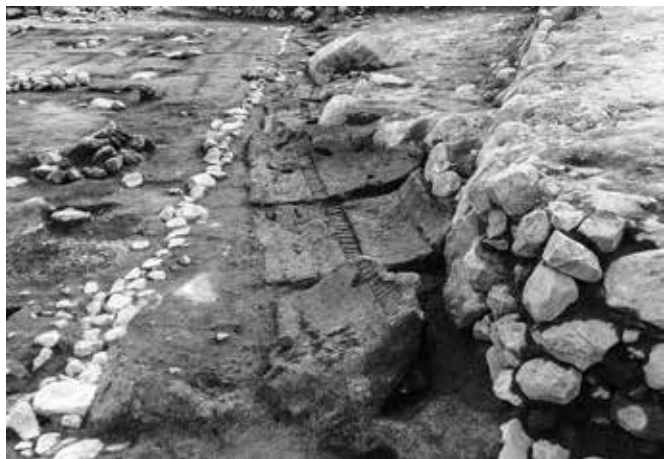
1 16号建物土壁(北から)
