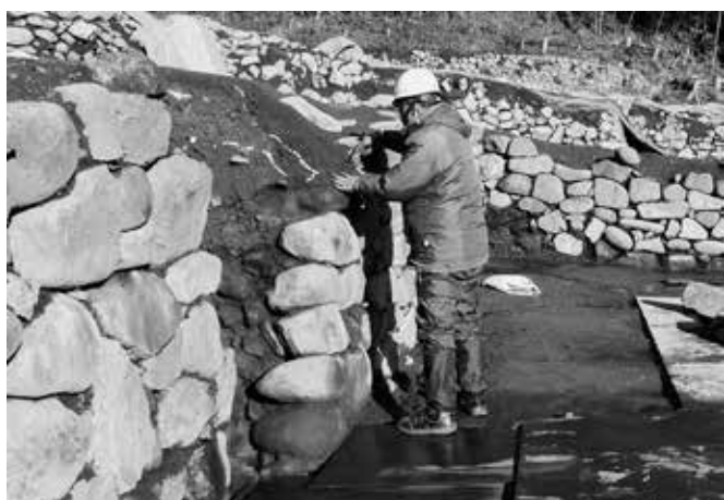
6 12号石垣解体状況(南東から)
