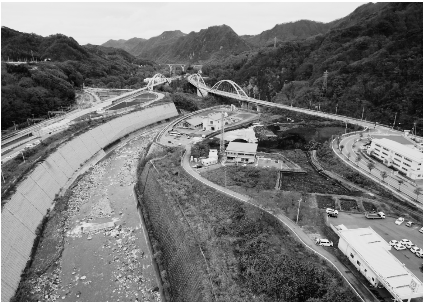
2 調査区 遠景 西から
