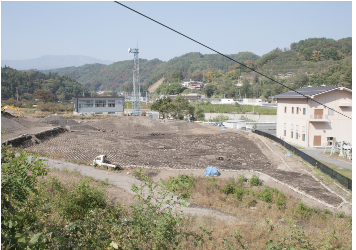
2 久々戸遺跡 天明泥流下畑 B区全景 南東から
