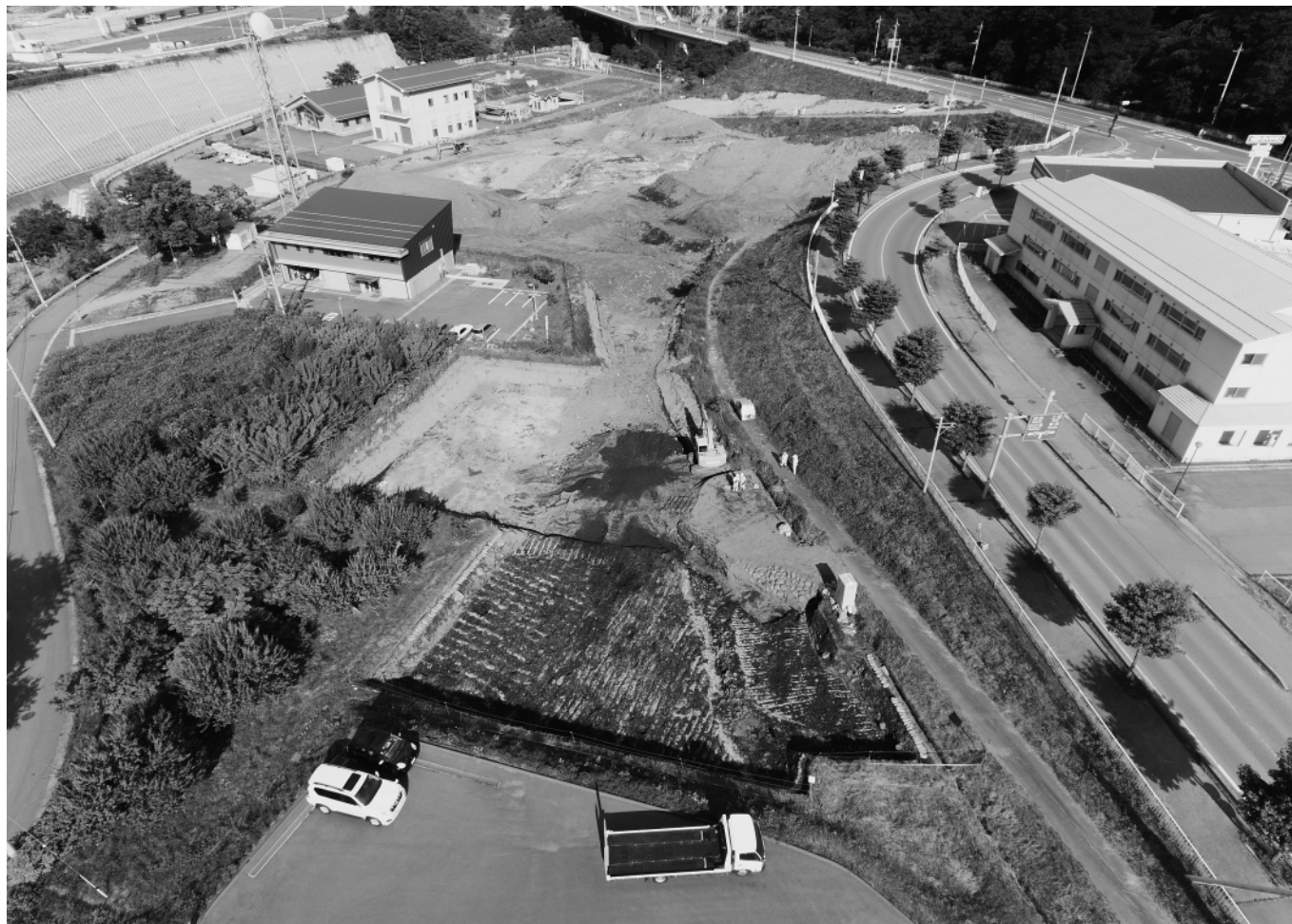
1 H28年度調査 1面 As-A泥流下畑全景 西から
