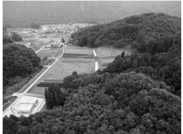
北方上空より調査地を望む
