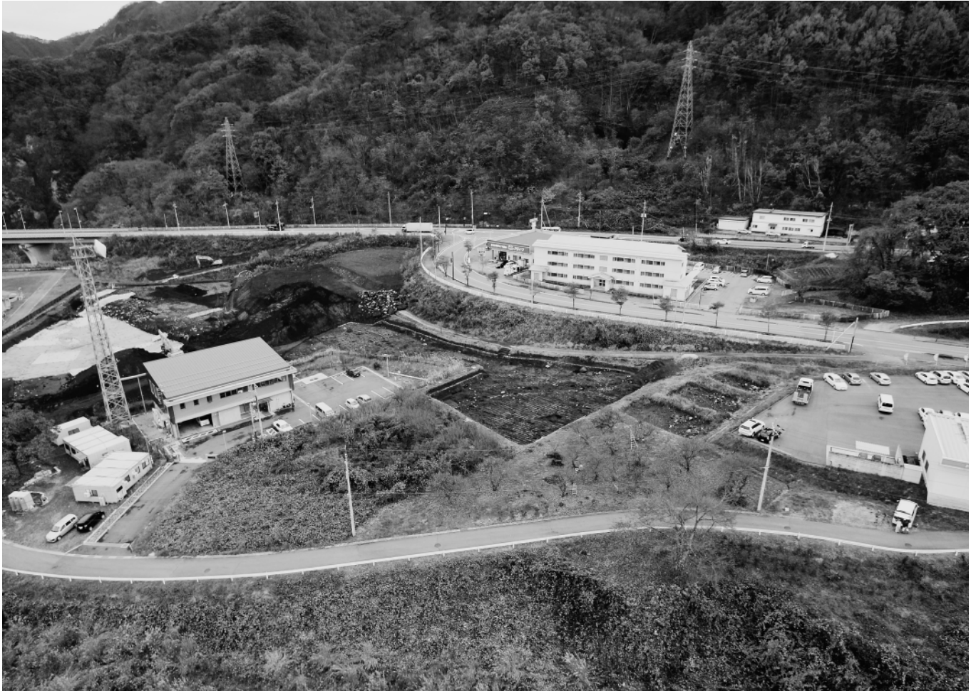
1 C区1面 As-A泥流下畑全景 北西から
