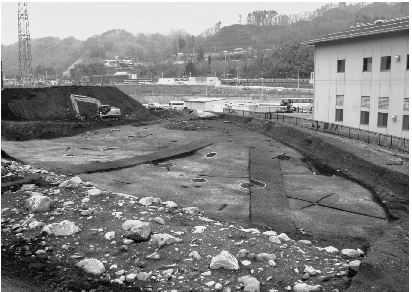
2 B区2面北側 土坑群全景 南東から
