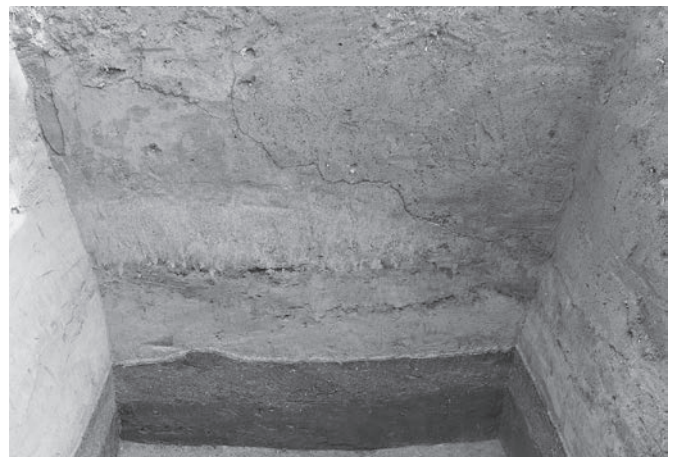
5. C 1 区土層断面(北から)
