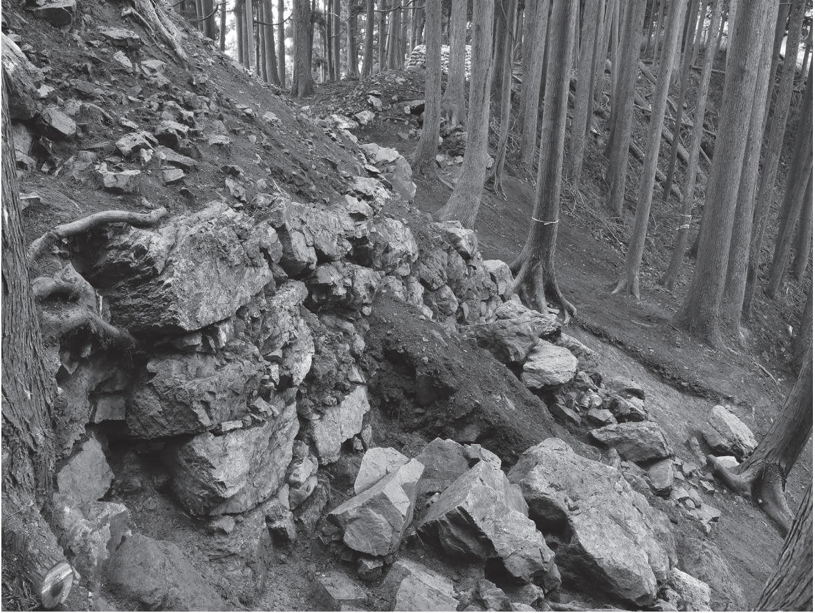
1 西櫓台石垣南西隅と転落石（南西から）
