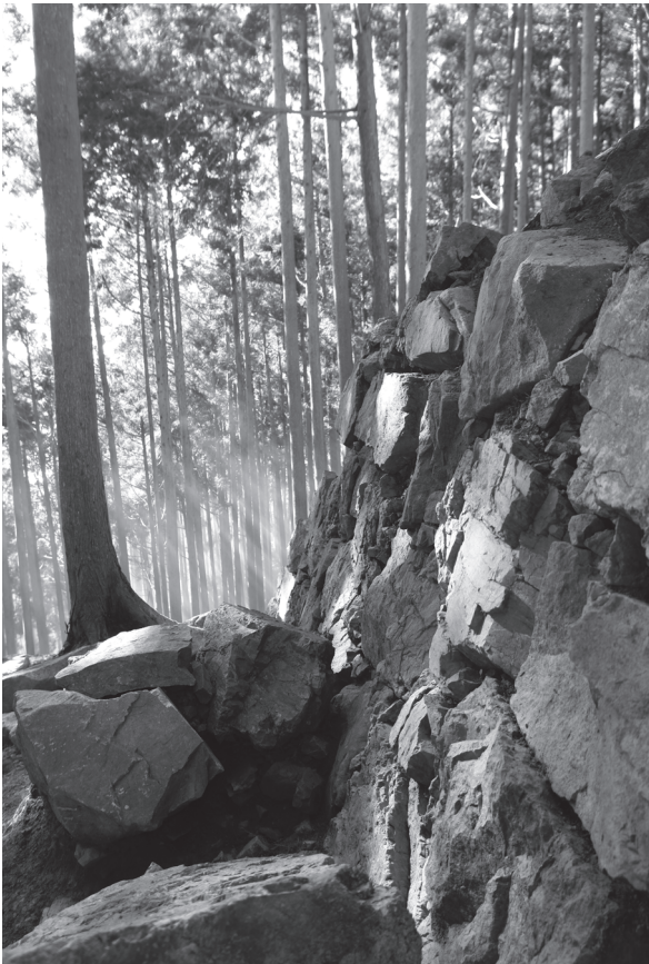
2 西櫓台東面石垣（北から）
