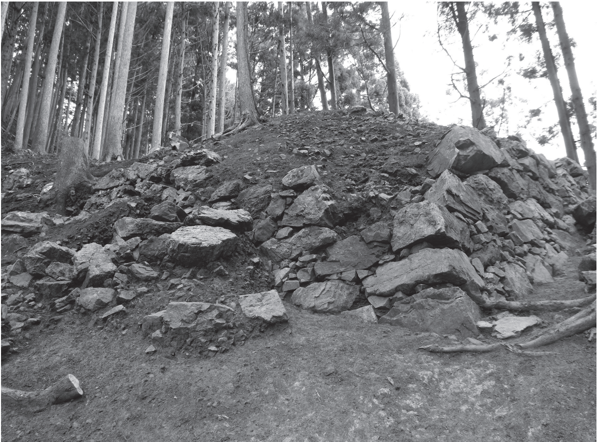
2 西櫓台石垣南東隅（南東から）
