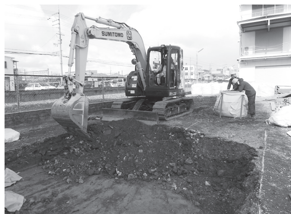
図3 重機掘削(南東から)
