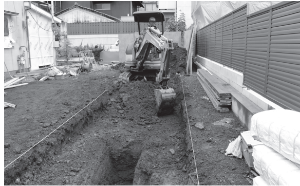
図2 重機掘削風景(南から)
