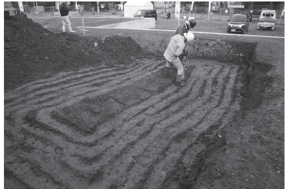
図5 1区埋め戻し状況（南西から）
