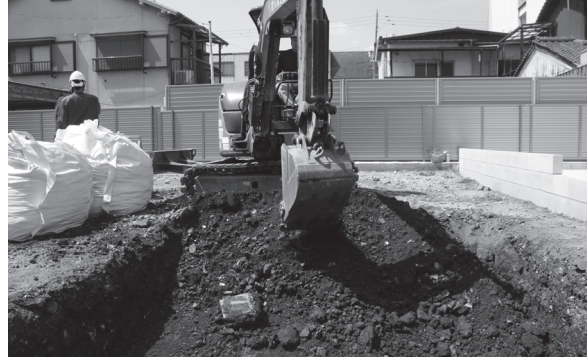
図3 重機掘削風景（北から）
