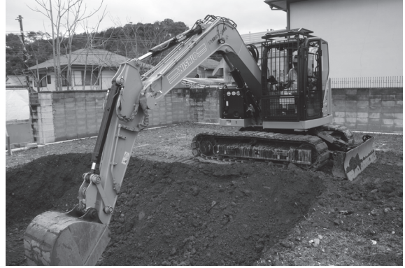
図3 1区重機掘削状況（北東から）
