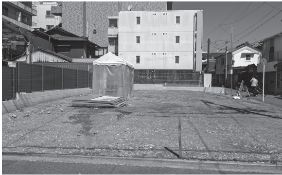
図2 調査前風景（南から）
