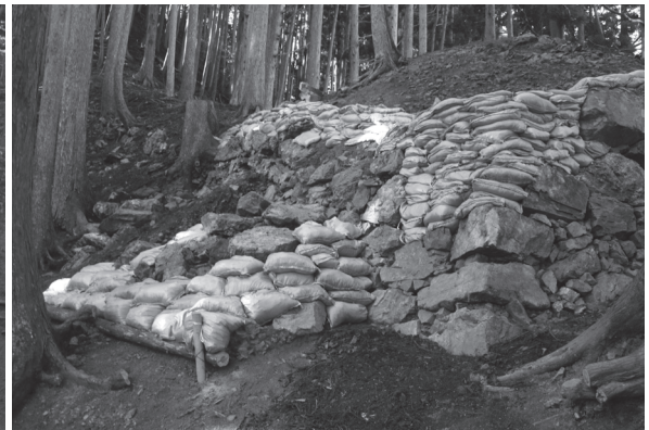
図7 西櫓台養生状況2（南東から）
