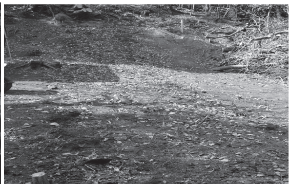
図6 1区埋め戻し完了状況（東から）
