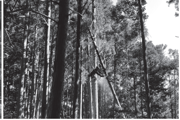
図3 危険木伐採状況（北西から）
