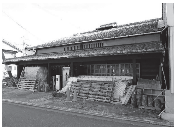
図2 被災前建物(南西から) 2)
