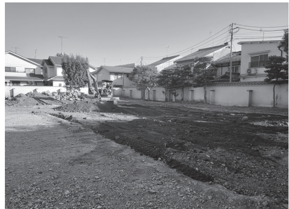
図5 埋め戻し風景（北西から）
