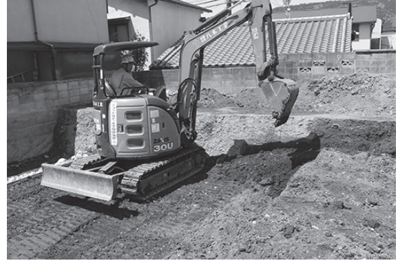
図3 2区重機掘削状況（北東から）
