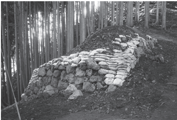
図6 西櫓台養生状況1（北東から）
