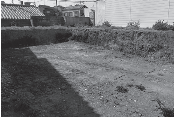
図2 調査前全景（南東から）
