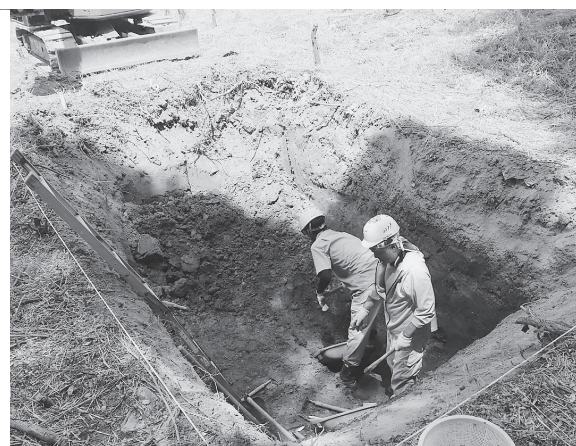
図5 人力掘削作業状況（南東から）
