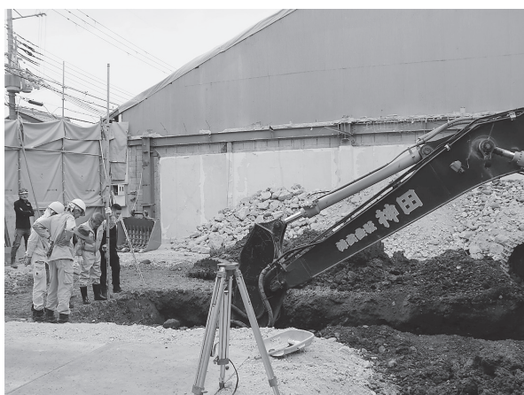
図4 重機掘削作業状況（東から）
