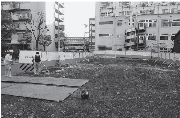
図3 調査前全景 (西から)
