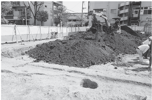
図5 3区埋め戻し状況 (南西から)
