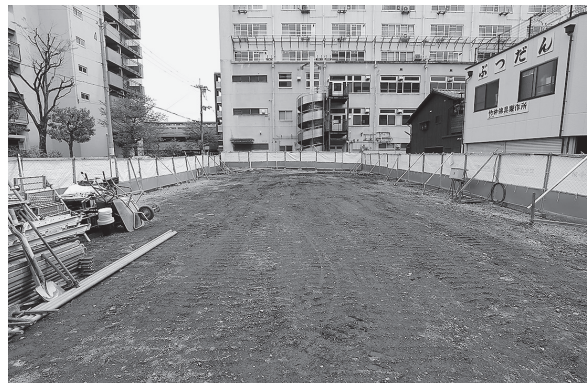
図6 埋め戻し後 (西から)
