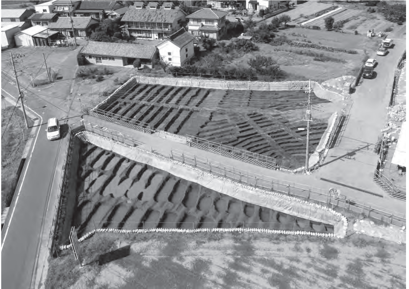
1 1-2・3区1面復旧溝群(南より)
