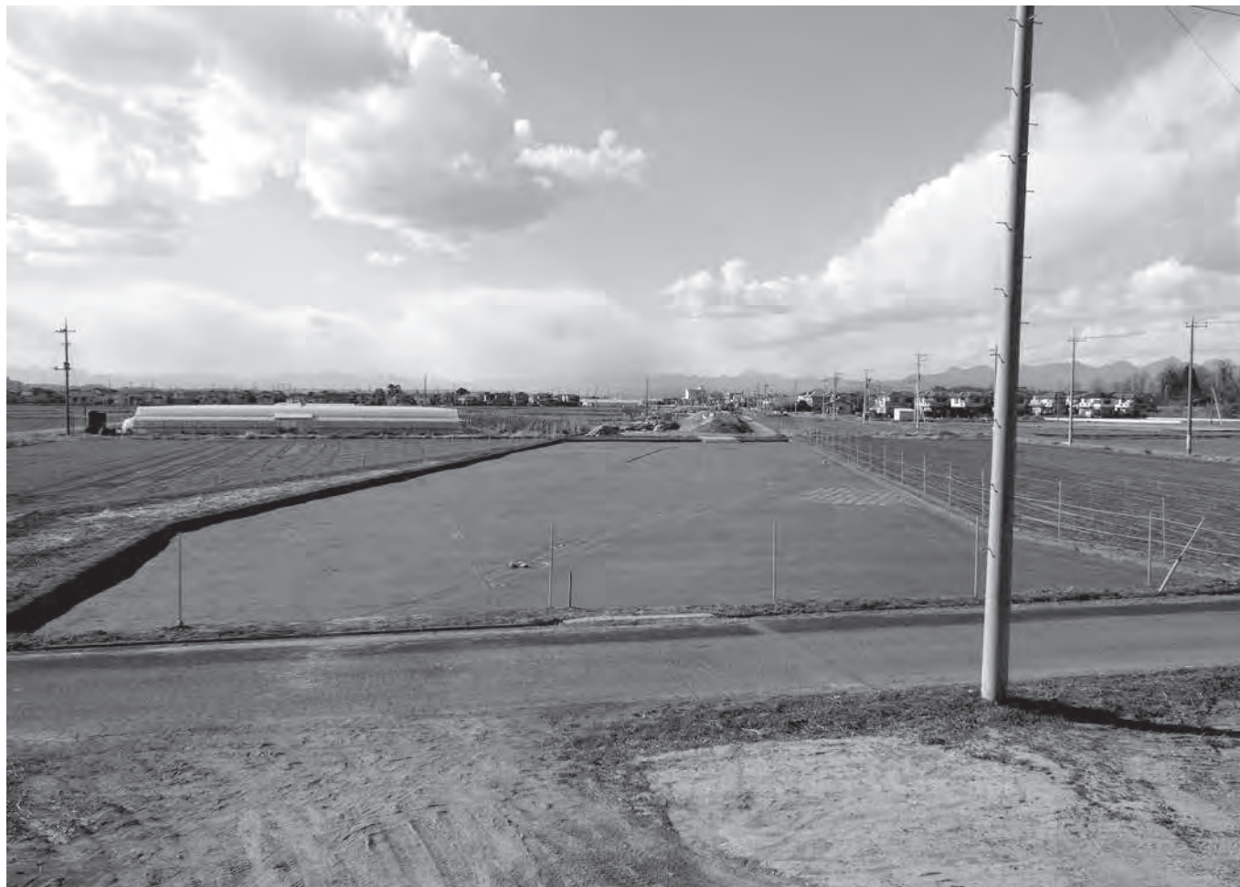
1 4区全景(東より)
