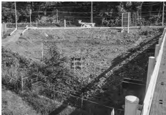
1. 1号建物調査前風景(南から)
