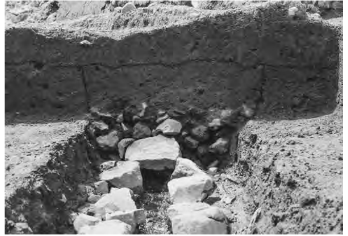
2. 1号暗渠断面(東から)
