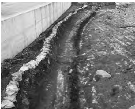
9. 16号道・20号溝(東から)
