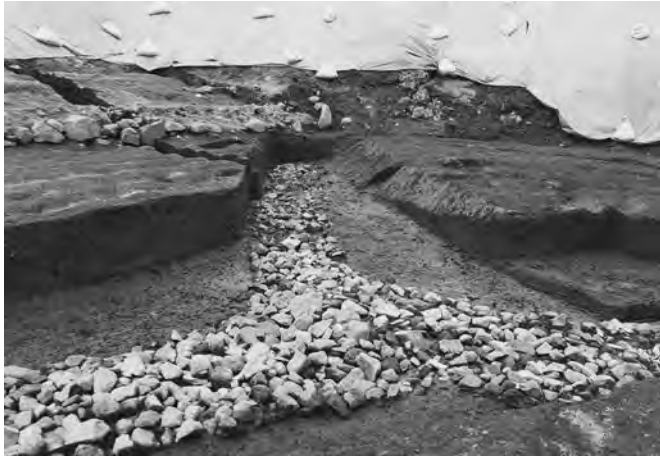
1. 1号暗渠(南西から)
