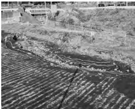
7. 10号道・9・11・12号溝・1号河道(南から)
