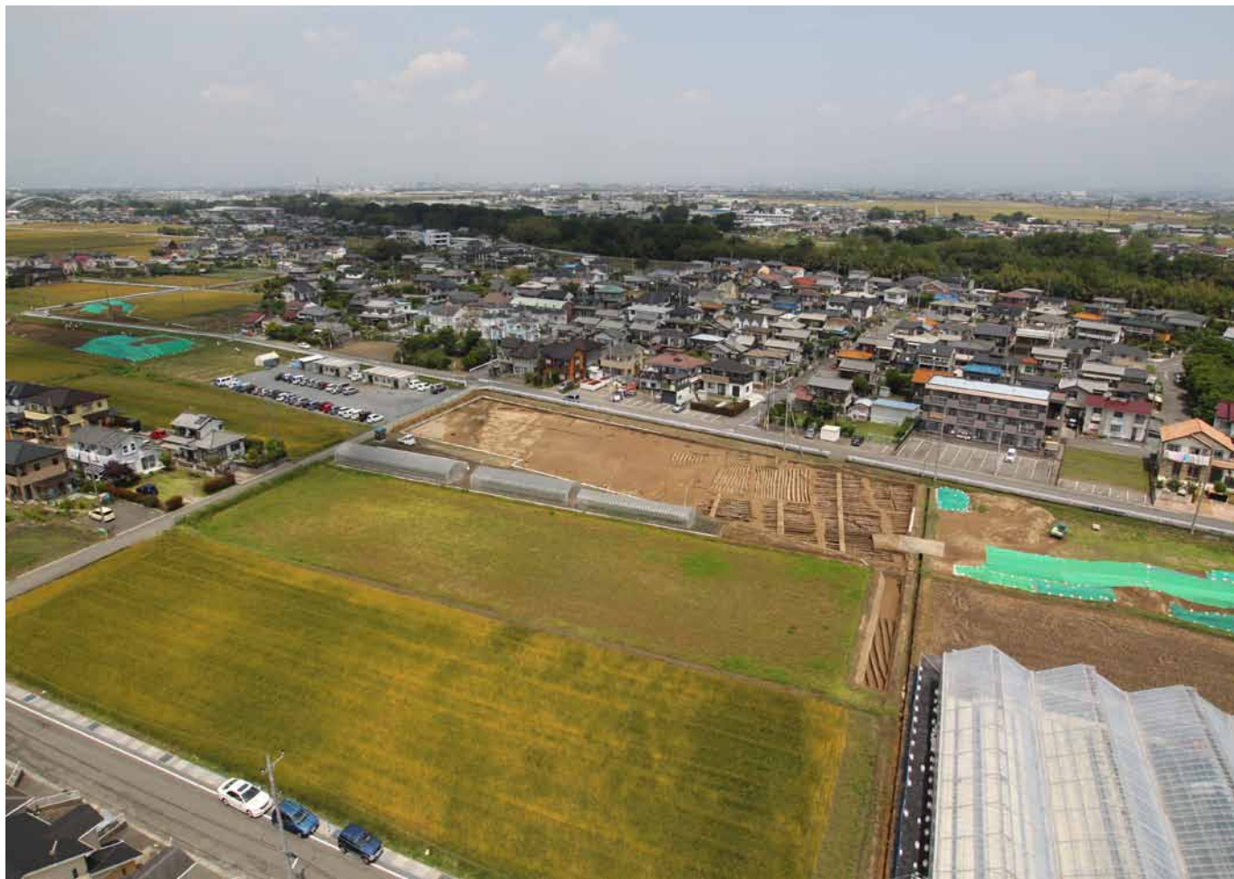
1. 3区第1面全景(南上空から)
