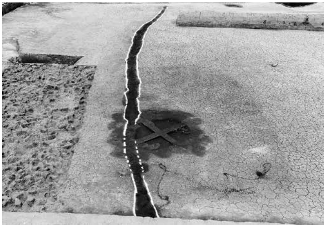
2 26号溝D全景 南から
