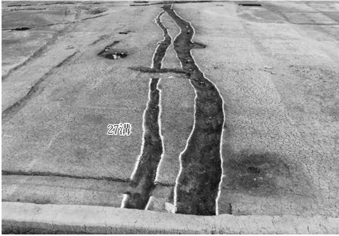
1 27号溝B全景 南から
