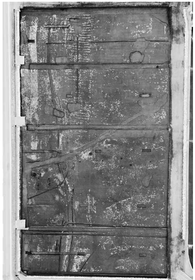
3 2区A～D 2面全景 南から
