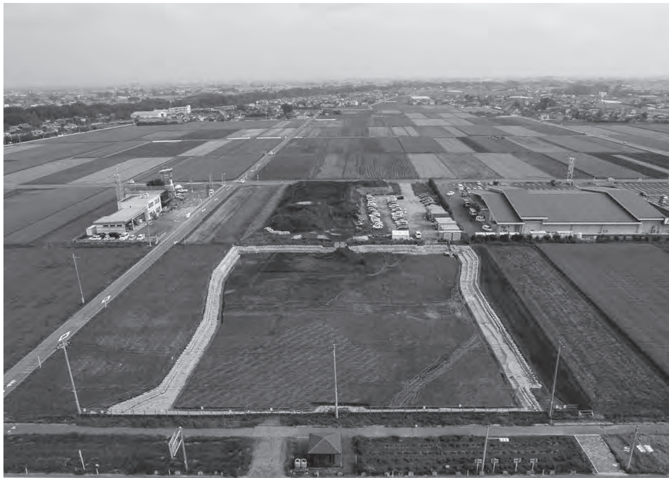
1 1区4面航空写真(西より)
