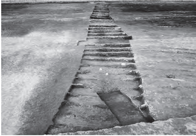
1 2区1号復旧溝群全景(南より)
