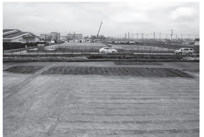
3 3区2号復旧溝群全景(東より)
