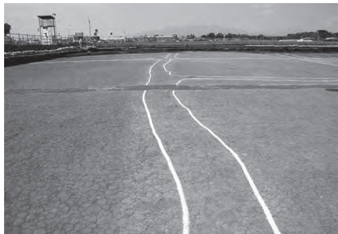
2 3区As-B下水田西部(南より)
