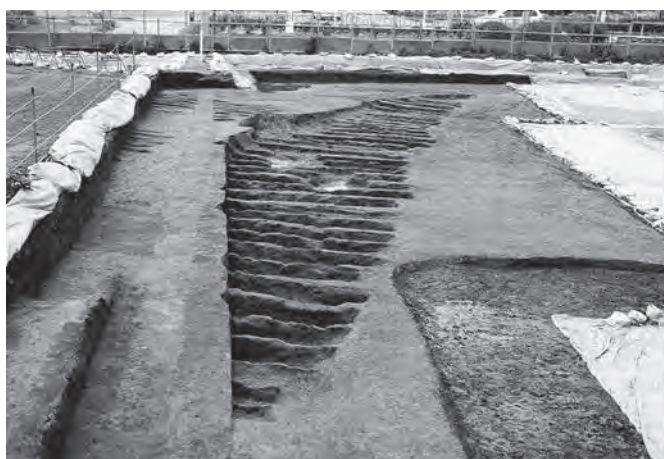
7 1区4号復旧溝群全景 (東より)
