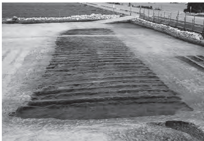
4 3区2号復旧溝群全景(北より)
