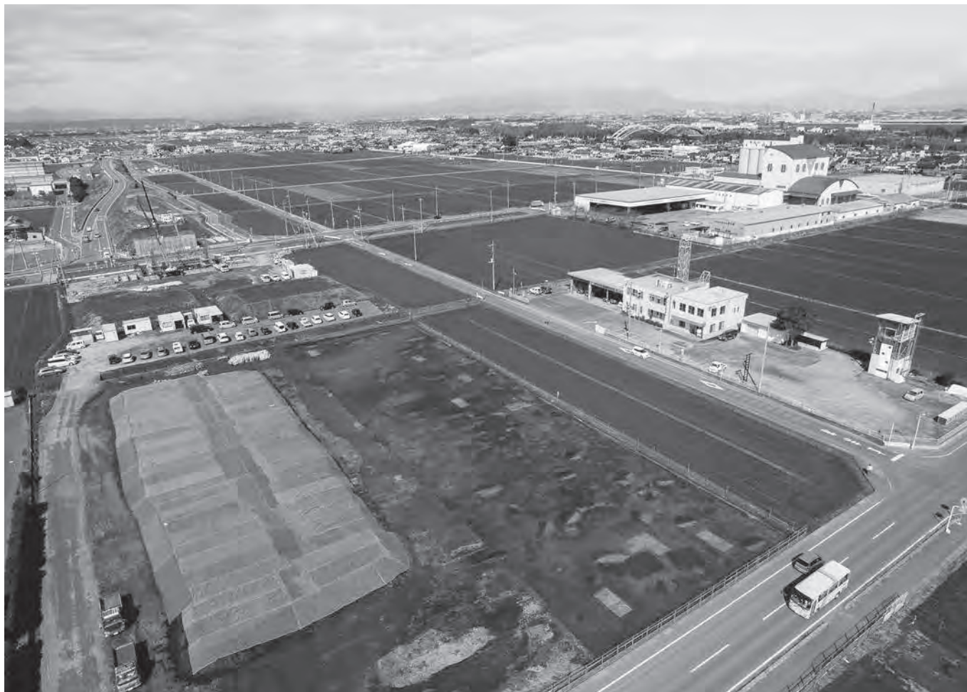
1 2区北半部4面航空写真(南東より)
