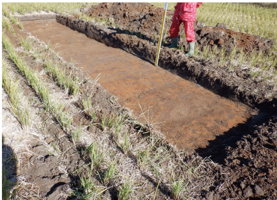
8号トレンチ土層状況 (南西→)
