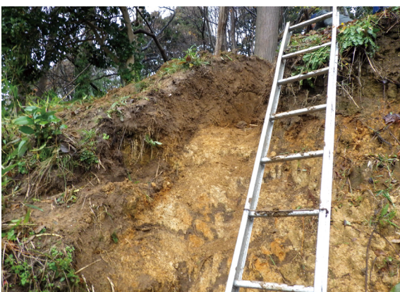
斜面地土層断面（西壁）
