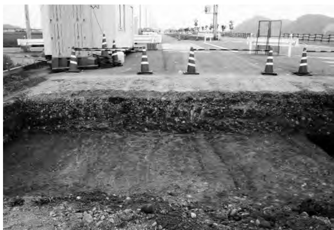
3 1区西端部トレンチ(南から)
