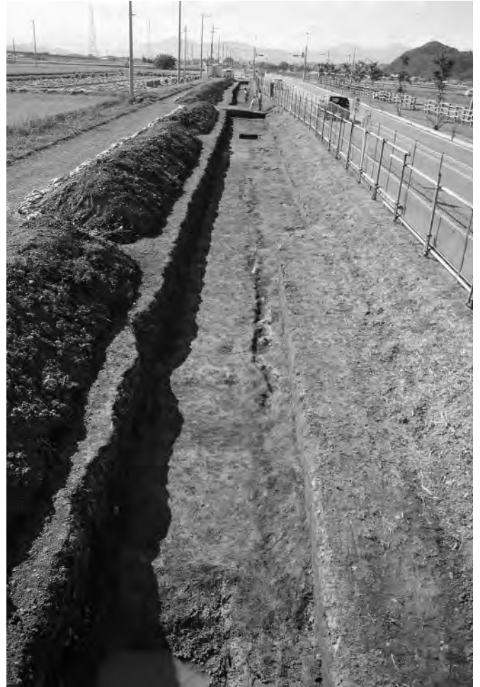
2 2区調査区西半分全景(東から)
