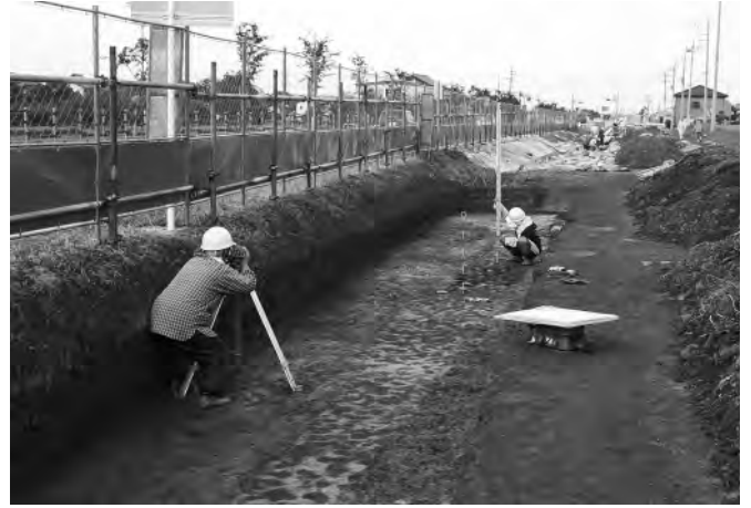
2 1区1号溝測量風景(西から)
