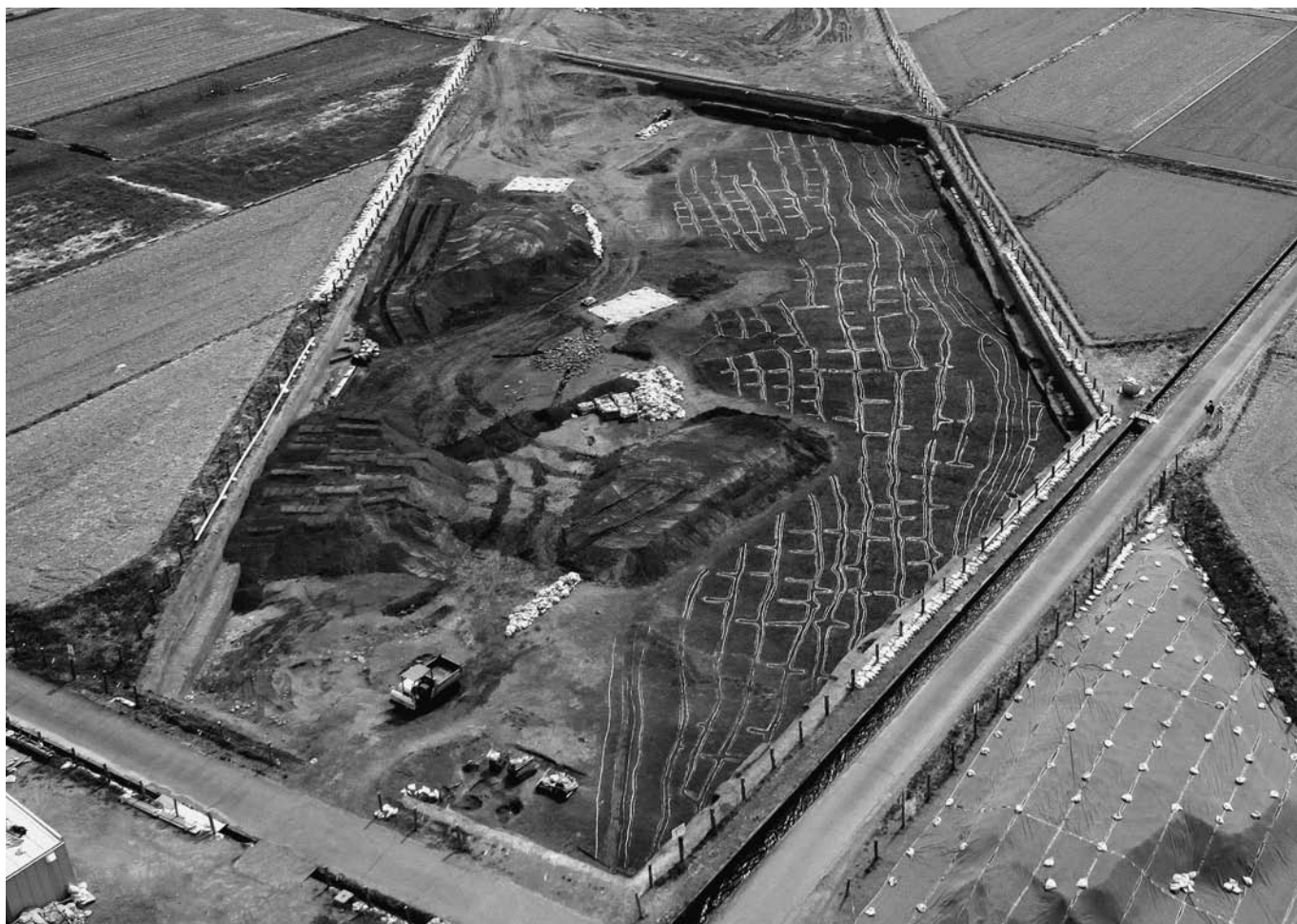
2 4区3面空撮(南側) 北西から
