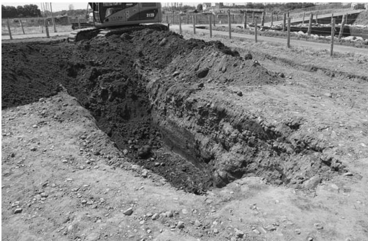
2 3区1面復旧溝確認トレンチ 北から
