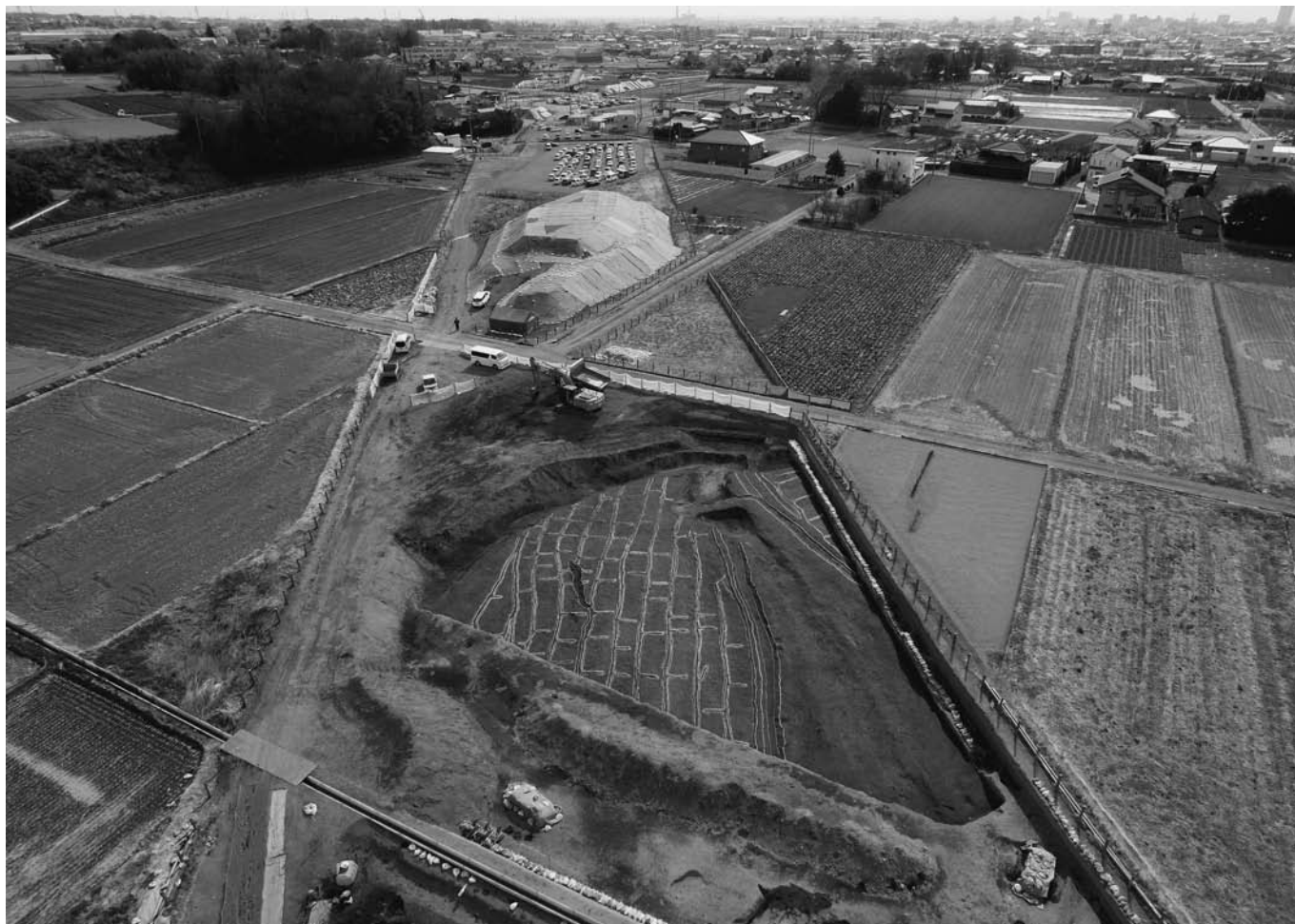
1 5区3面水田空撮 西上空から
