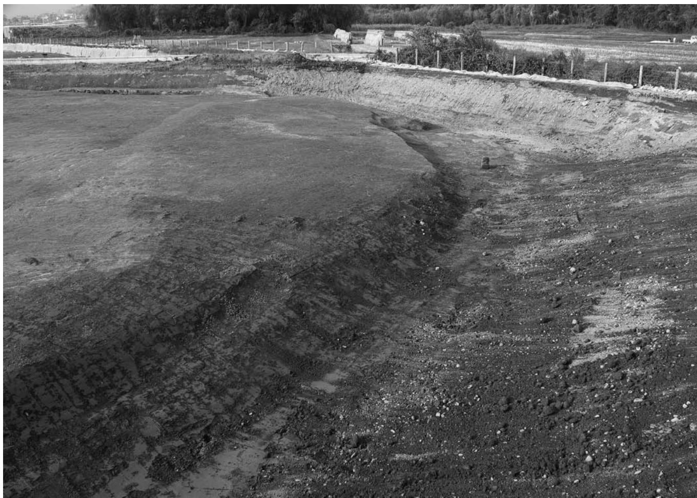
7 5区1面3河道全景 南から
