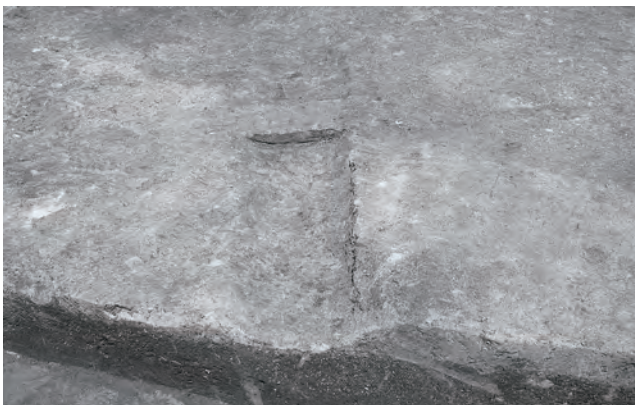
▲3区2面6溝 南から
