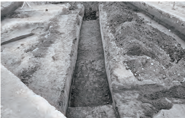
▲1区下層確認トレンチ掘削状況
