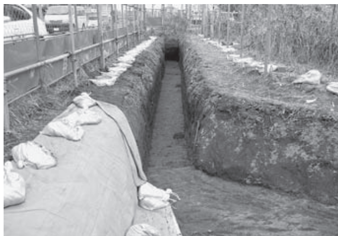
4. 3区北西部全景(南から)
