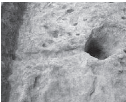
13. 1区4号竪穴住居P 1 南側間仕切り溝(南東から)
