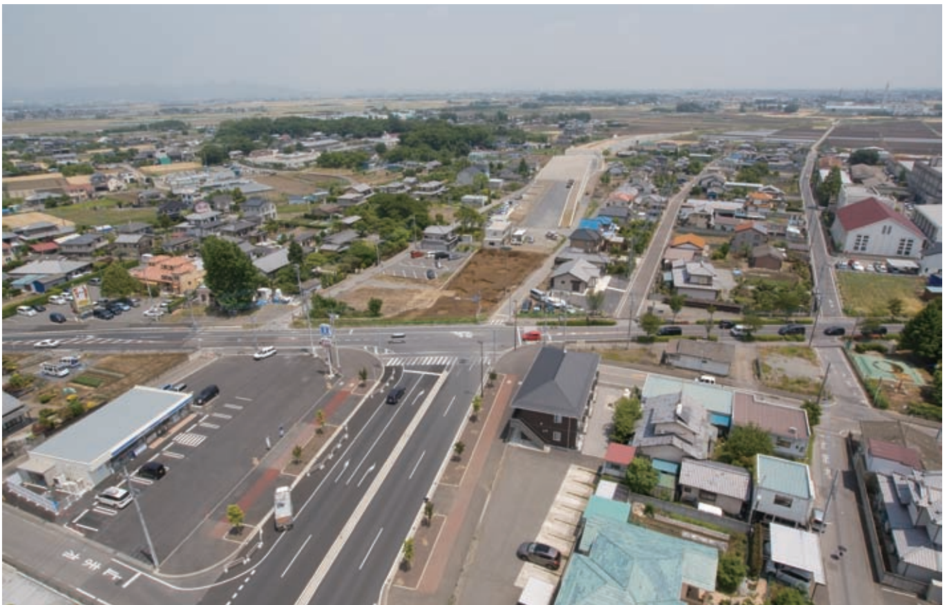
4. 間之原遺跡3区遠景（西上空から）
