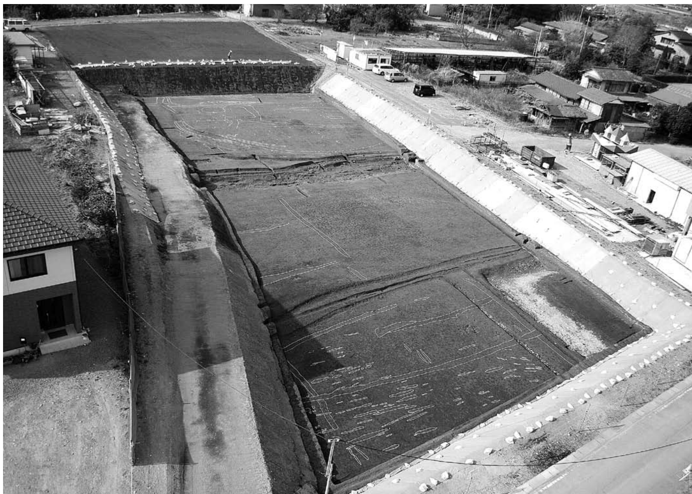
5. 1区5面東側水田・耕作痕全景(南東から)
