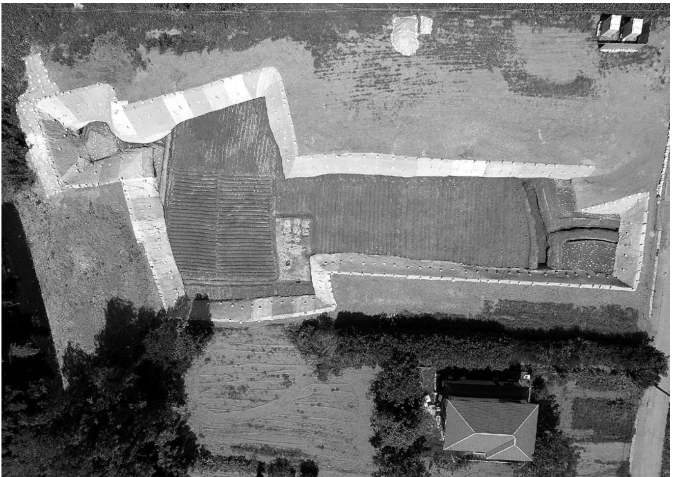
2.5区2面全景(上空から)
