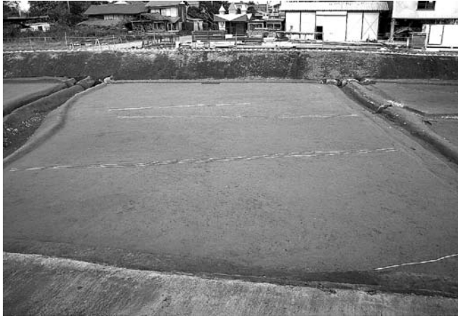
1. 1区4面中央付近水田疑似畦畔全景(南から)
