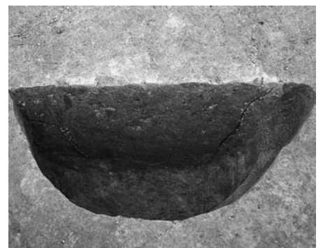
⑦ 6号掘立柱建物P 5断面(南より)
