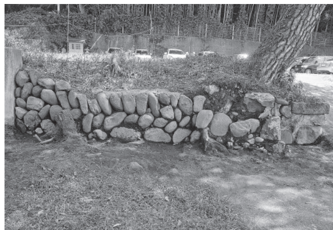
3 尋常小学校跡地 南辺石垣 残存状況 南から
