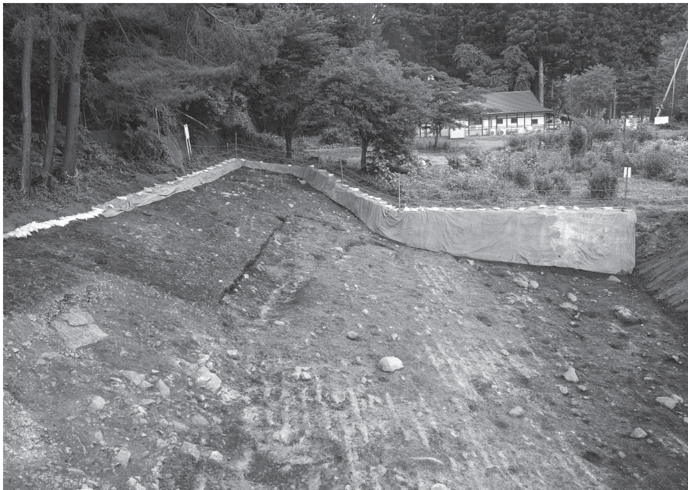
1 平成23年度調査 33区 6号畑-1 全景 西から
