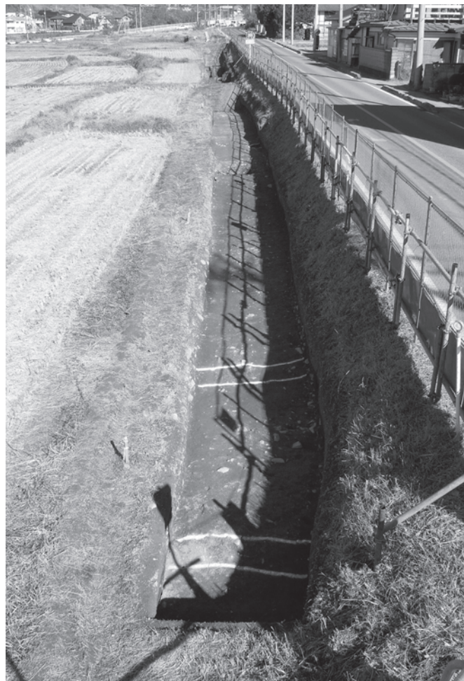
2. 調査区(南半)全景(南より)
