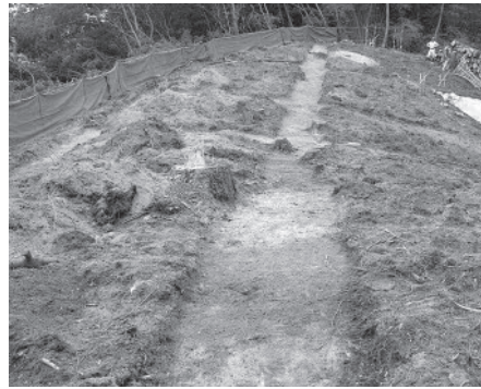
5 トレンチ調査(南東から)
