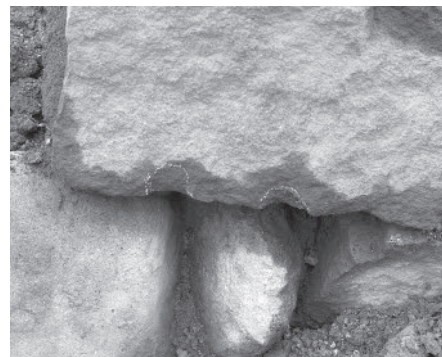
8 2号石垣矢跡の残る石(南から)
