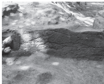
5 1号礎石建物土層断面(西から)
