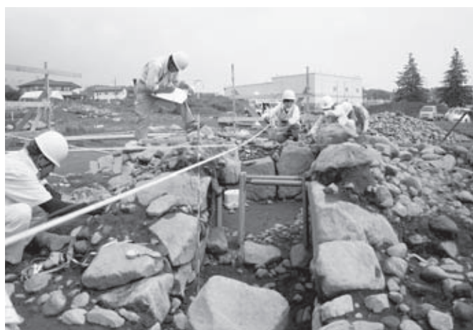
5 石室石材の計測と解体(南から 54号墳)
