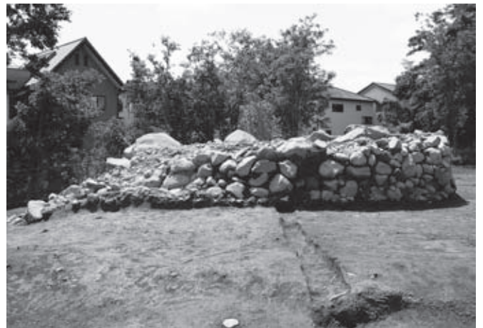
3 裏込め東側面(東から)
