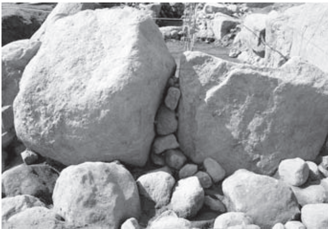
3 裏側から見た奥壁1・2間の間詰め(北から)
