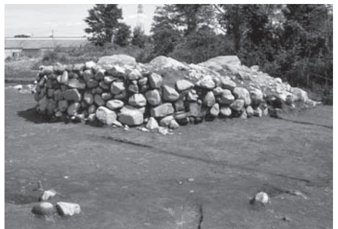
4 裏込め側面(西から)
