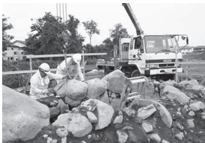
6 石室の解体・石材吊り上げ(北西から 54号墳)
