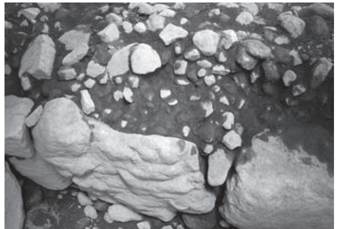
3 奥壁と裏込め(南西から)
