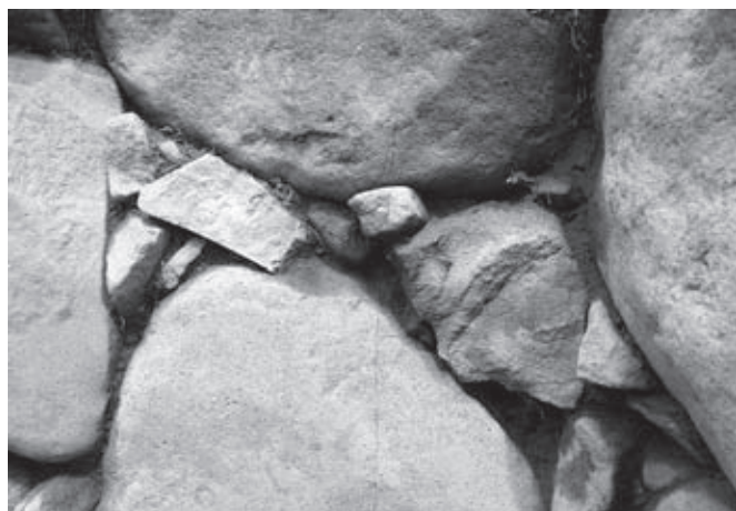
5 西壁6・12・17間の間詰め(東から)
