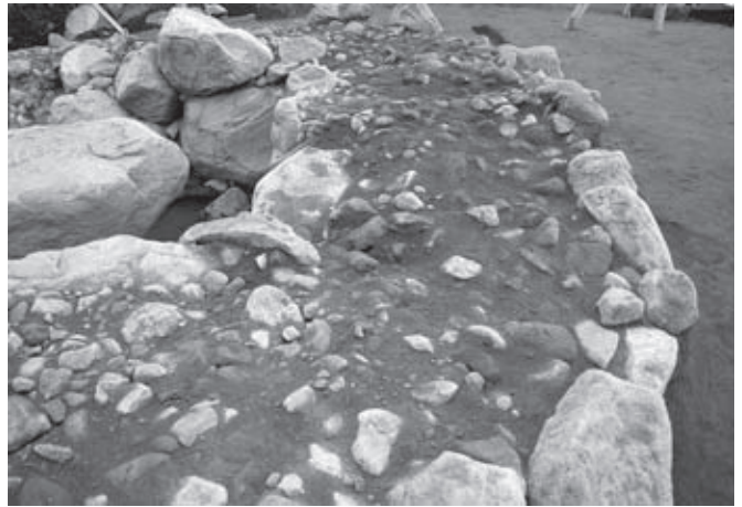
6 奥壁第1石面の裏込め(南東から)
