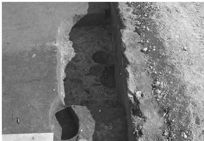
3区60号住居掘り方全景(西から)
