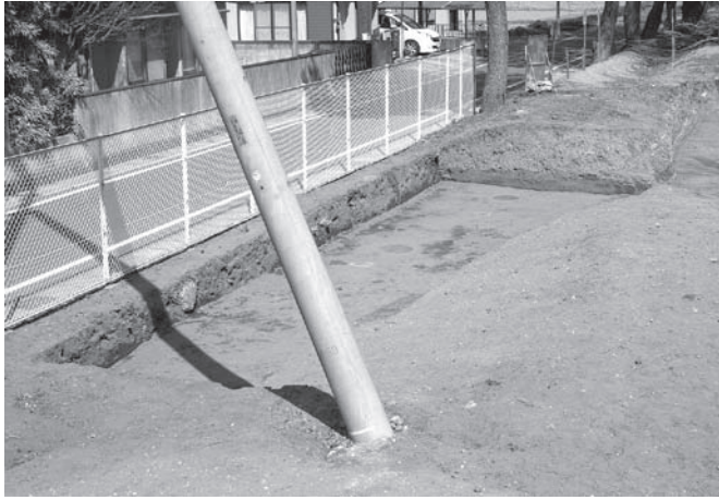
1 5-2区北端部全景(南から)
