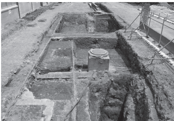
2区-①西側全景 西から
