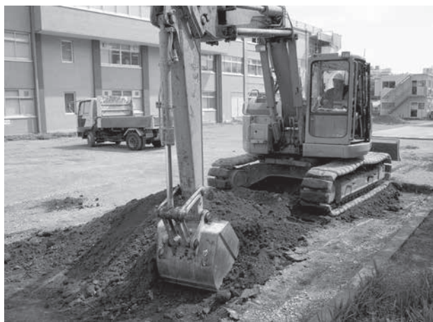
1区の表土掘削
