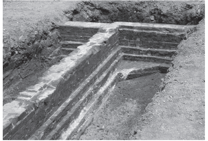
2区-②煉瓦とコンクリートの基礎2 西から
