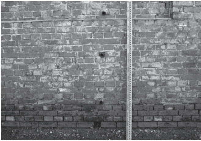
支え壁13・14間表面水抜き穴(北より)
