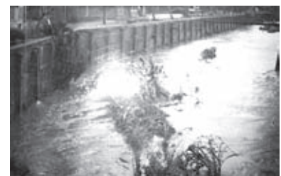
写真5 増水時の当遺構 (クラシエフーズ(株)新町工場 提供)
