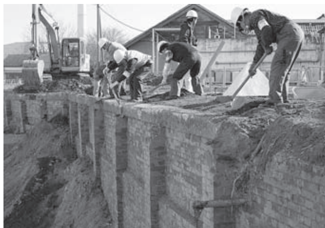
護岸上面表出作業(北西より)
