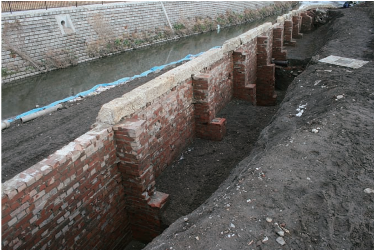
煉瓦積護岸背面（手前は支え壁 12、南東より）
