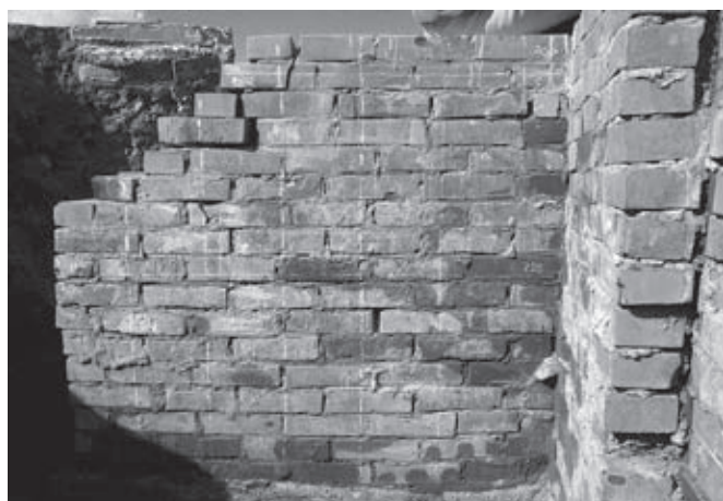
支え壁21背面側側面(東より)
