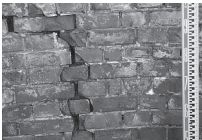
屈曲部表面煉瓦積(北より)
