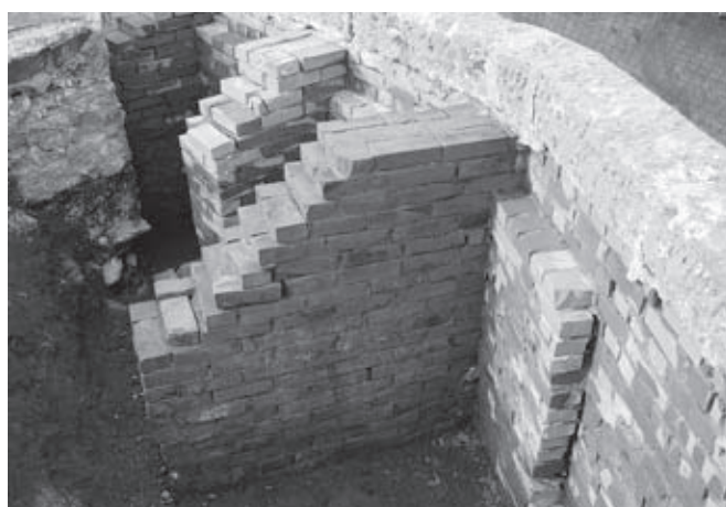
背面支え壁21屈曲付近側面(東より)
