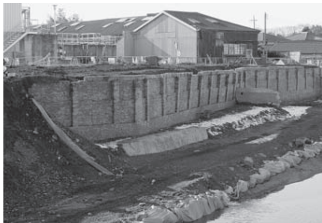
煉瓦積護岸表面全景（南東より）
