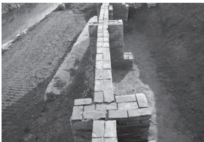
支え壁16・17付近煉瓦積頂部(西より)
