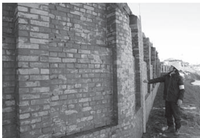
煉瓦積護岸屈曲部表面全景（東より）
