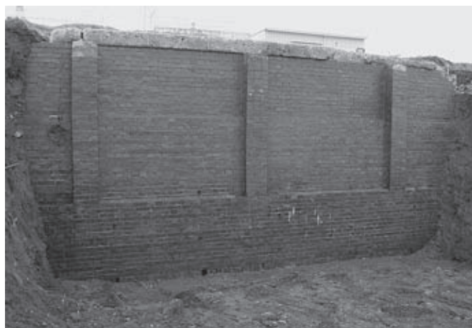
煉瓦積護岸東部表面（北より）
