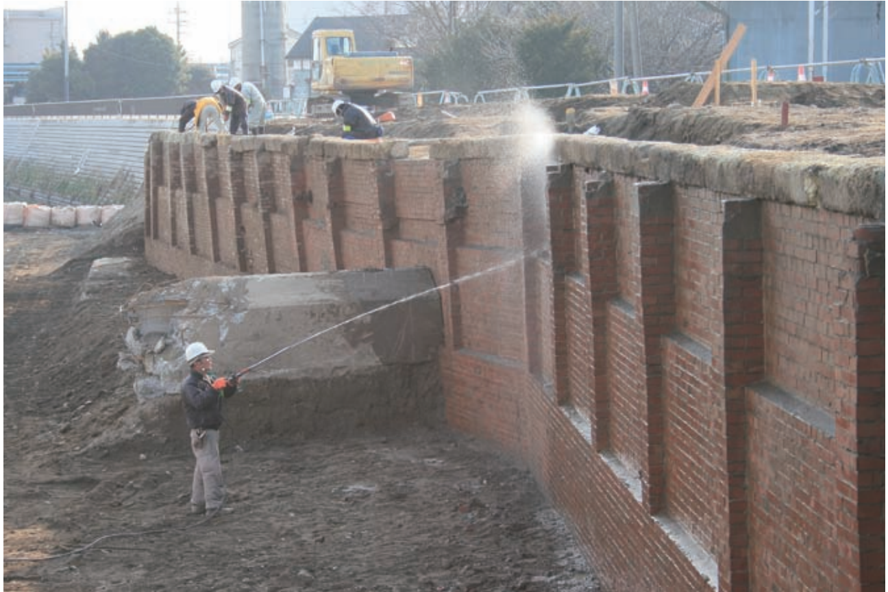
煉瓦積護岸表面の洗浄（西より）
