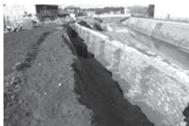
写真2 敷地側(直線部)
