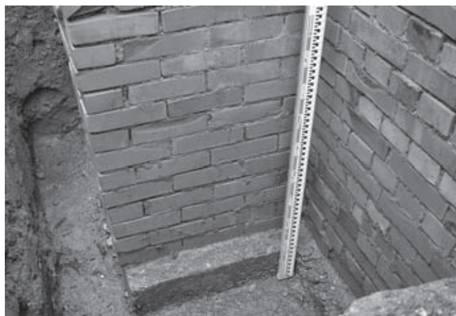
支え壁14基礎コンクリート(南東より)
