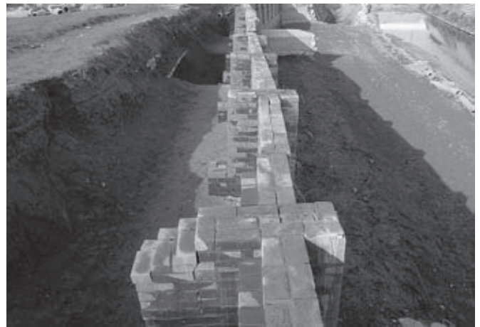
石列除去後の煉瓦積護岸上面(東より)
