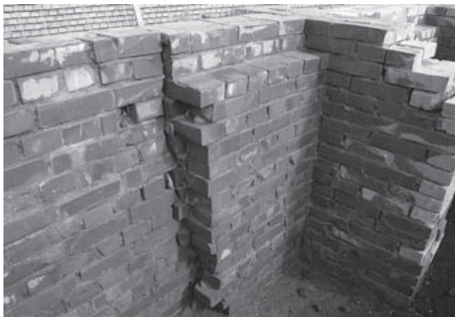
背面支え壁18付近面変換部(南西より)
