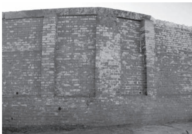
煉瓦積護岸屈曲部表面（北より）
