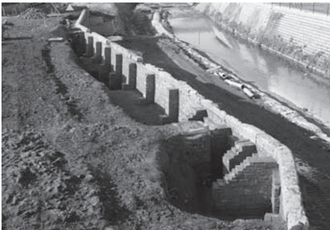
煉瓦積護岸背面(南東より)
