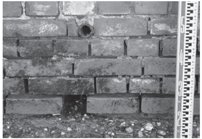
水抜き穴表面下位(北より)
