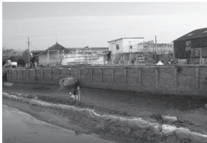
煉瓦積護岸表面全景（北西より）
