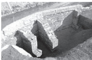
写真3 敷地側(屈曲部)
