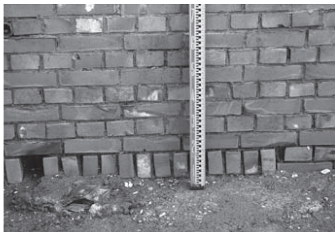
煉瓦積護岸東部表面下位（北より）
