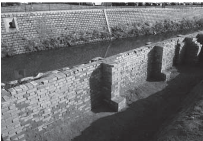
支え壁16・17背面(南西より)
