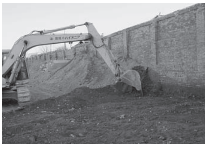
機械掘削状況(北より)
