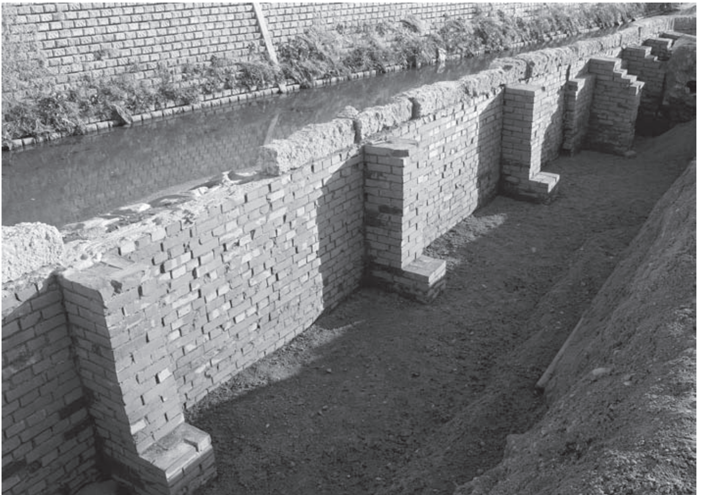
煉瓦積護岸背面（南西より）
