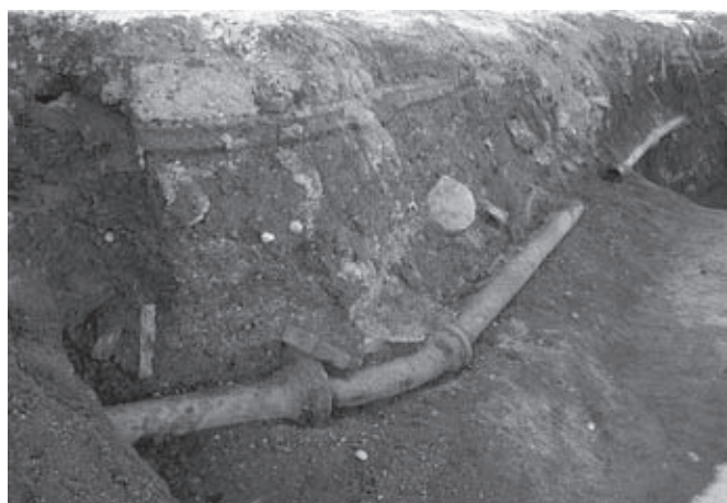
背面消火栓管全景(北東より)
