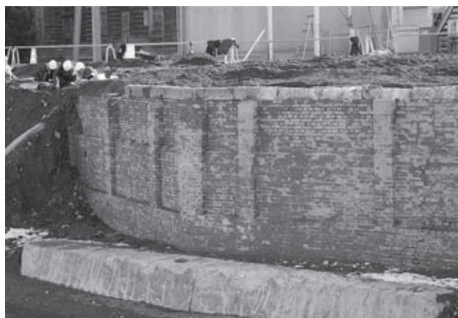
煉瓦積護岸屈曲部表面（北西より）
