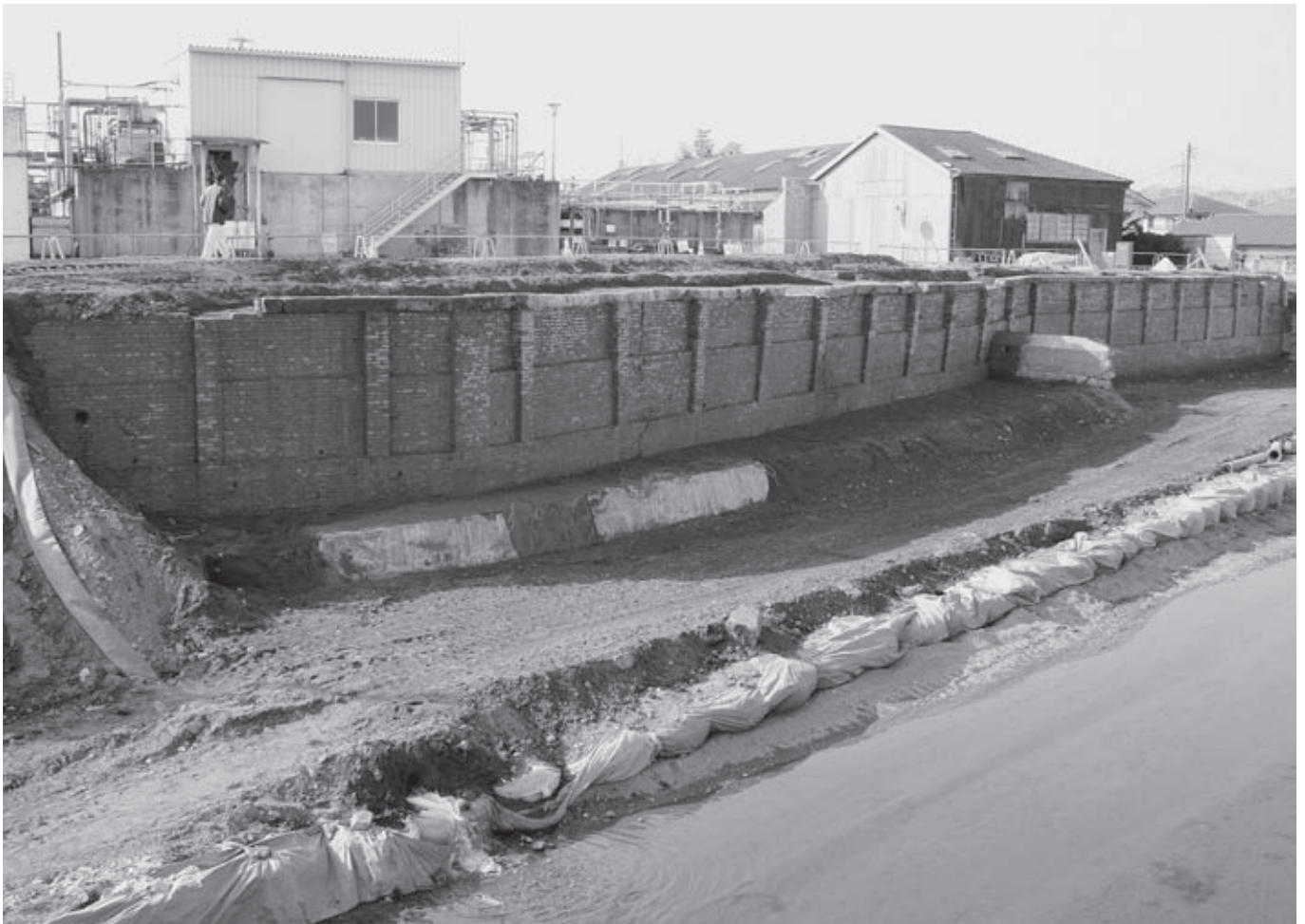
煉瓦積護岸表面（北東より）
