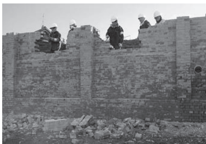
煉瓦部分解体作業(北より)
