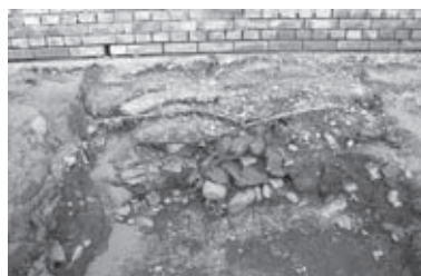
写真4 基礎底部(河川側)
