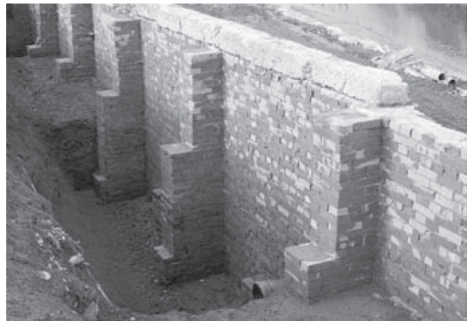
支え壁13・14・15背面(南東より)
