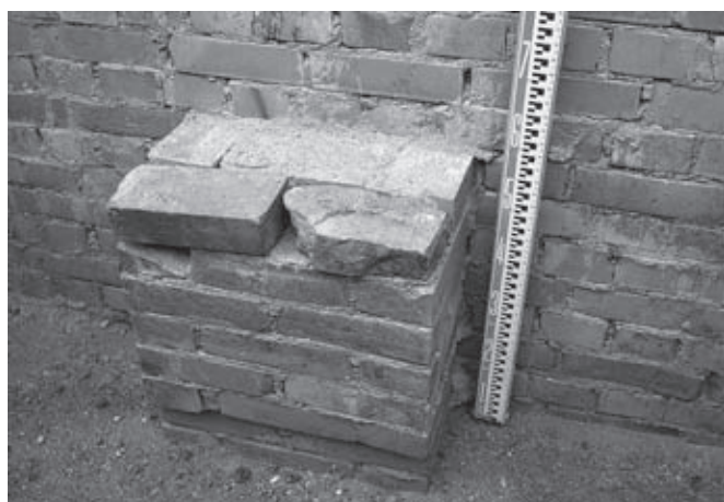
背面支え壁a(北より)
