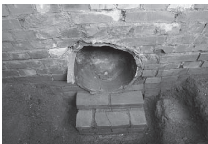
1号埋設管 護岸連結部(南より)
