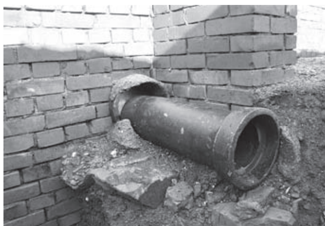
2号埋設管(背面、南西より)
