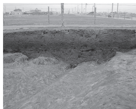
2区17号溝セクション(西から)
