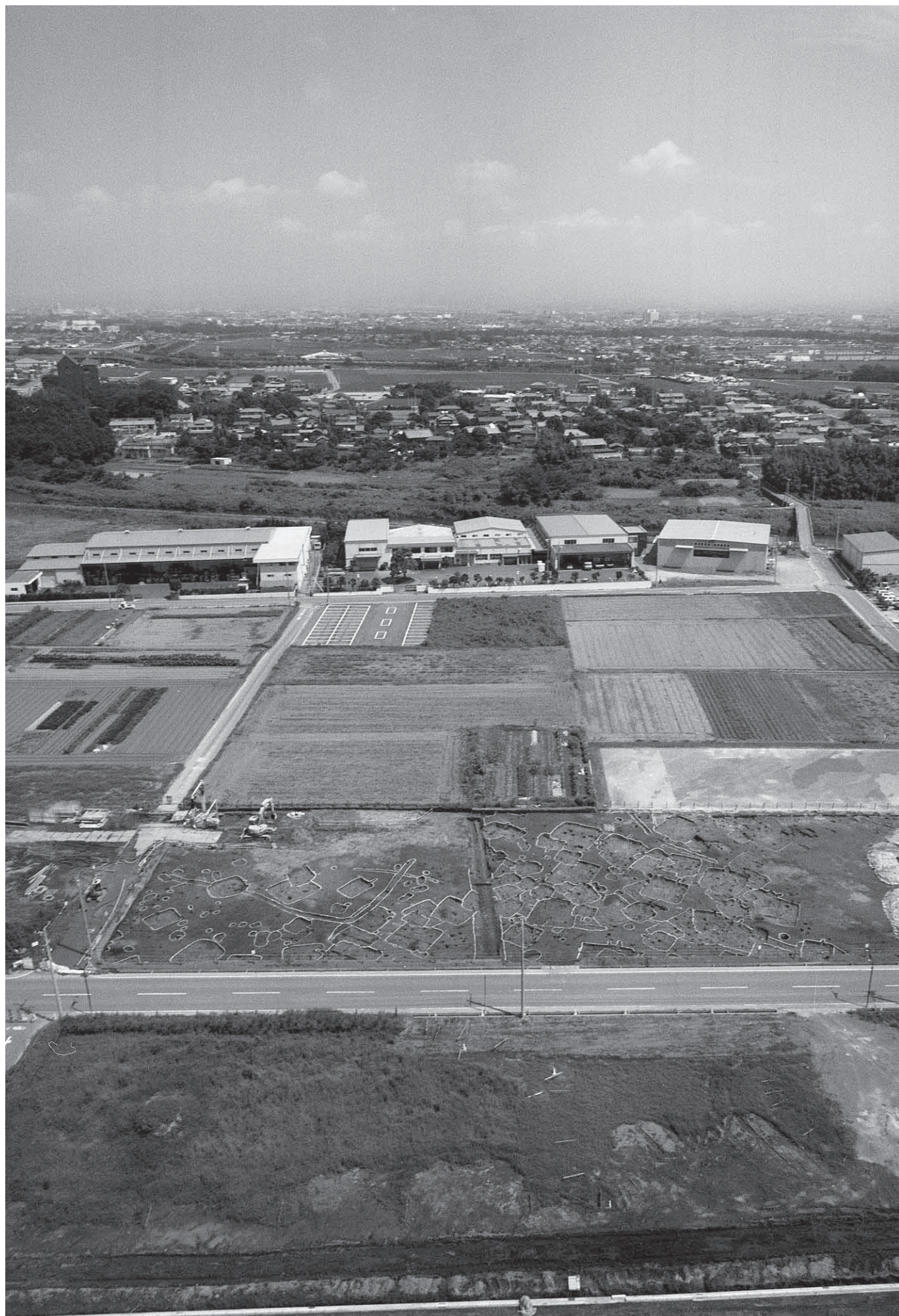
1区空中写真(南から)
