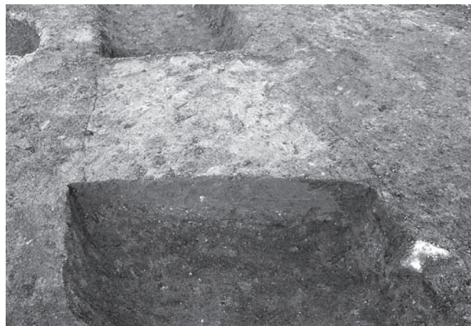
② 5号溝断面(南から)
