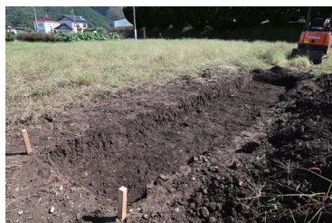
完掘状況(南西から)
