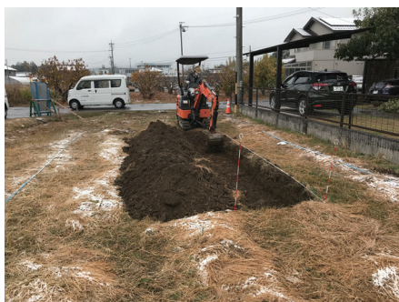
調査風景(東から)
