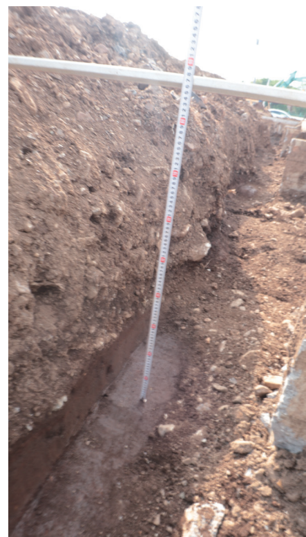
写真2 立会箇所の堆積状況
