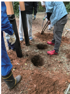
4 柱穴掘削風景
