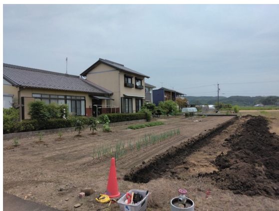
掘削風景（西から）
