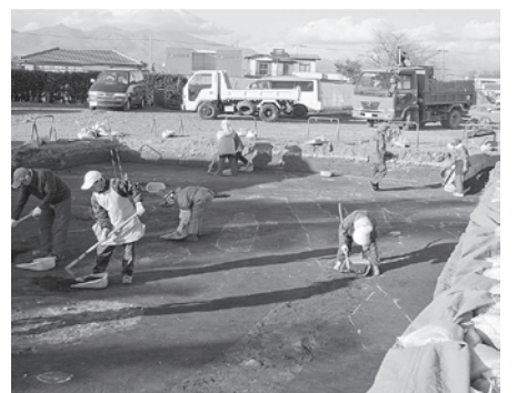
15. 3区作業風景(南から)
