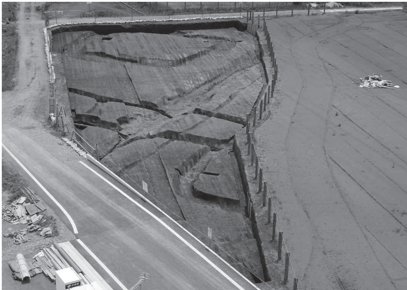
Ⅲ区全景 北西より
