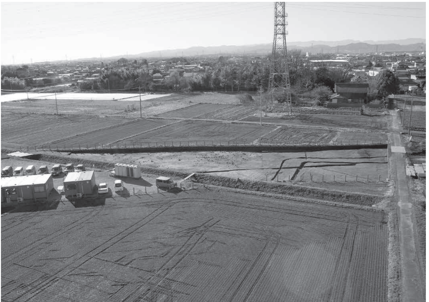
II区全景 北より
