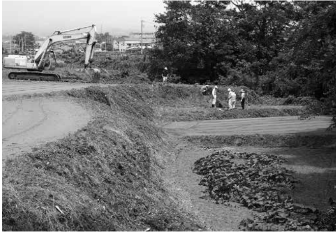
1. 無名沢調査前風景(南西から)
