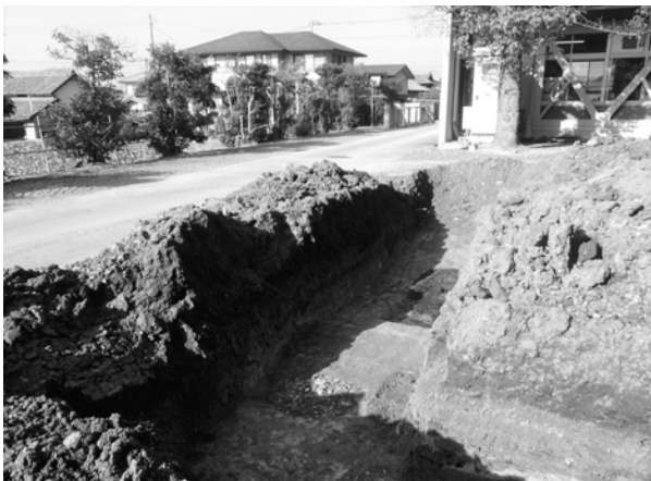
写真 70 4 トレンチ 南東から
