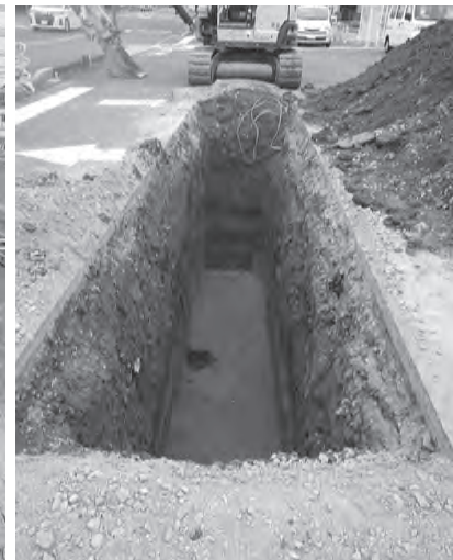
写真 43 4 トレンチ 南から
