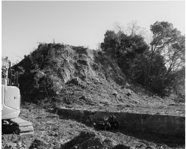
写真20 34・35 トレンチ東方の丘陵西斜面 西から
