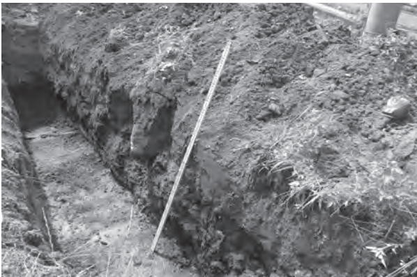
写真 22 36 トレンチ 西から
