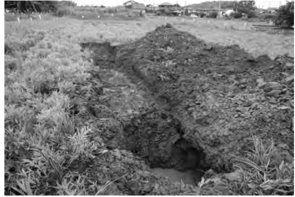
写真9 11 トレンチ 南東から
