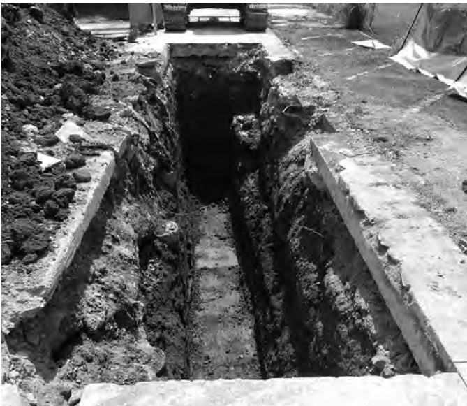
写真 46 9 トレンチ 南から
