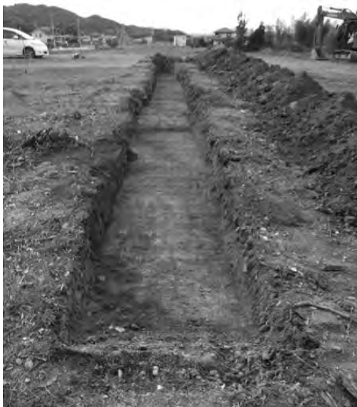
写真17 35 トレンチ 東から
