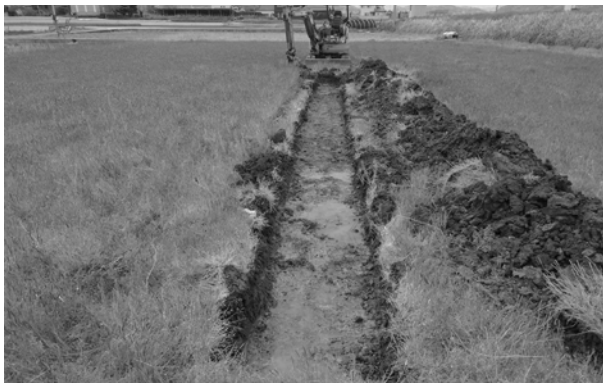
写真 58 13 トレンチ全景 北から
