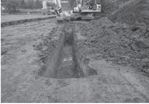
写真 84 1 トレンチ 南東から
