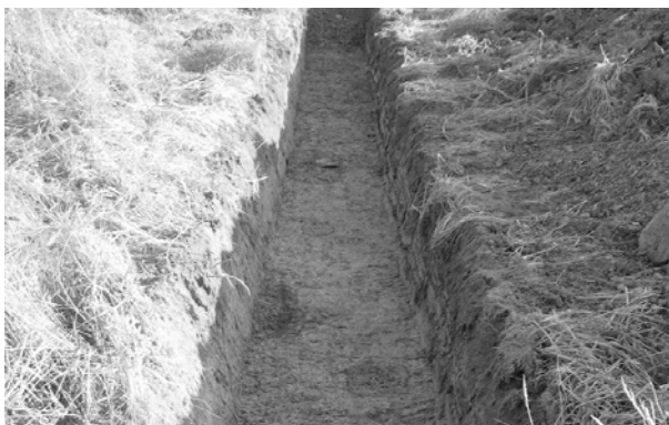
写真 60 20 トレンチ遺構検出状況 北から
