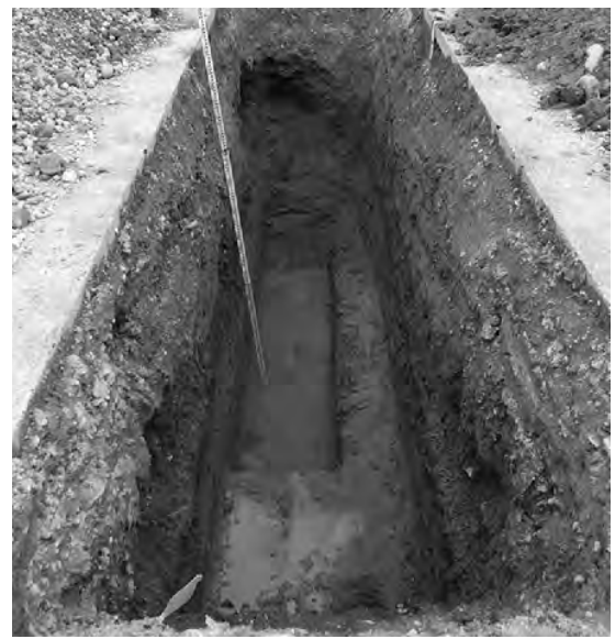
写真 47 11 トレンチ 南から
