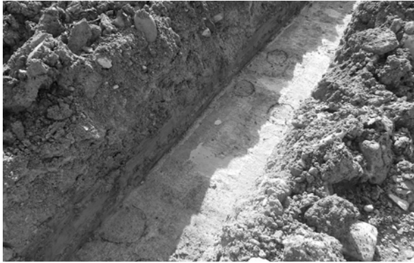
写真 56 11 トレンチ柱穴群検出状況 北東から
