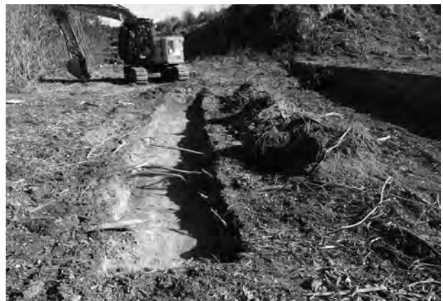
写真21 34 トレンチ 西から
