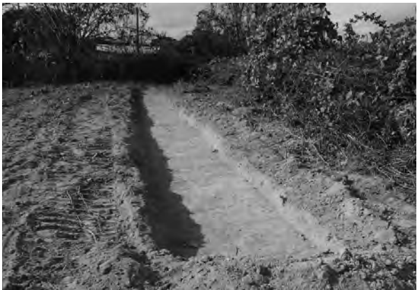
写真 90 5 トレンチ 東から
