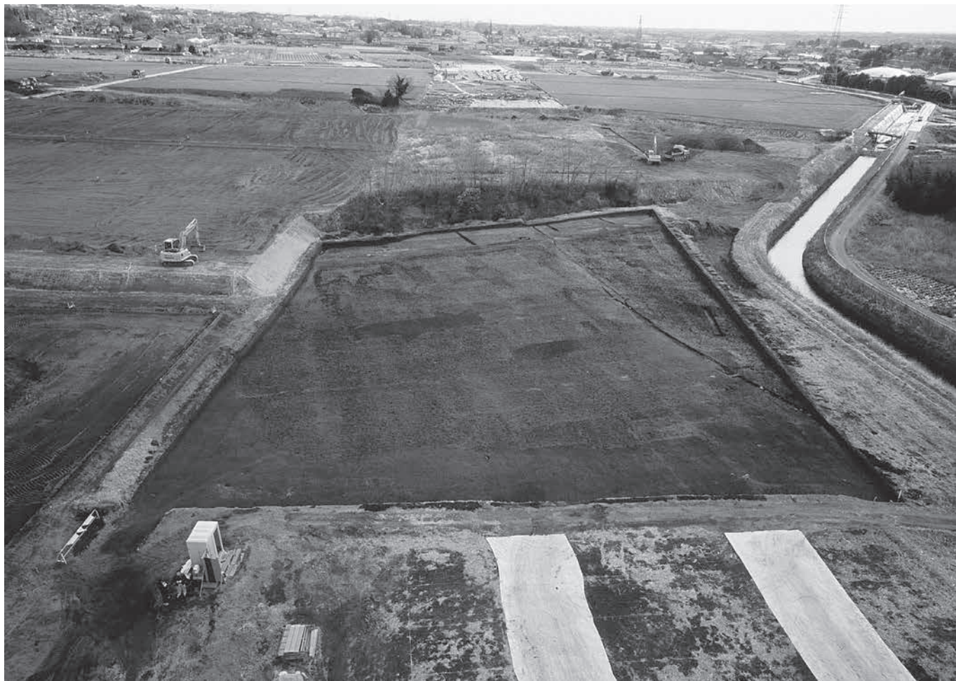
1 A区As-B下水田全景(北西から、丑子遺跡を望む)
