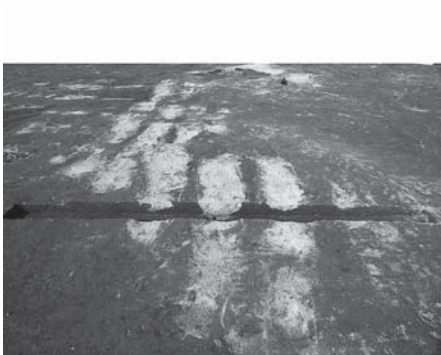
1区4号復旧溝群セクション(西から)
