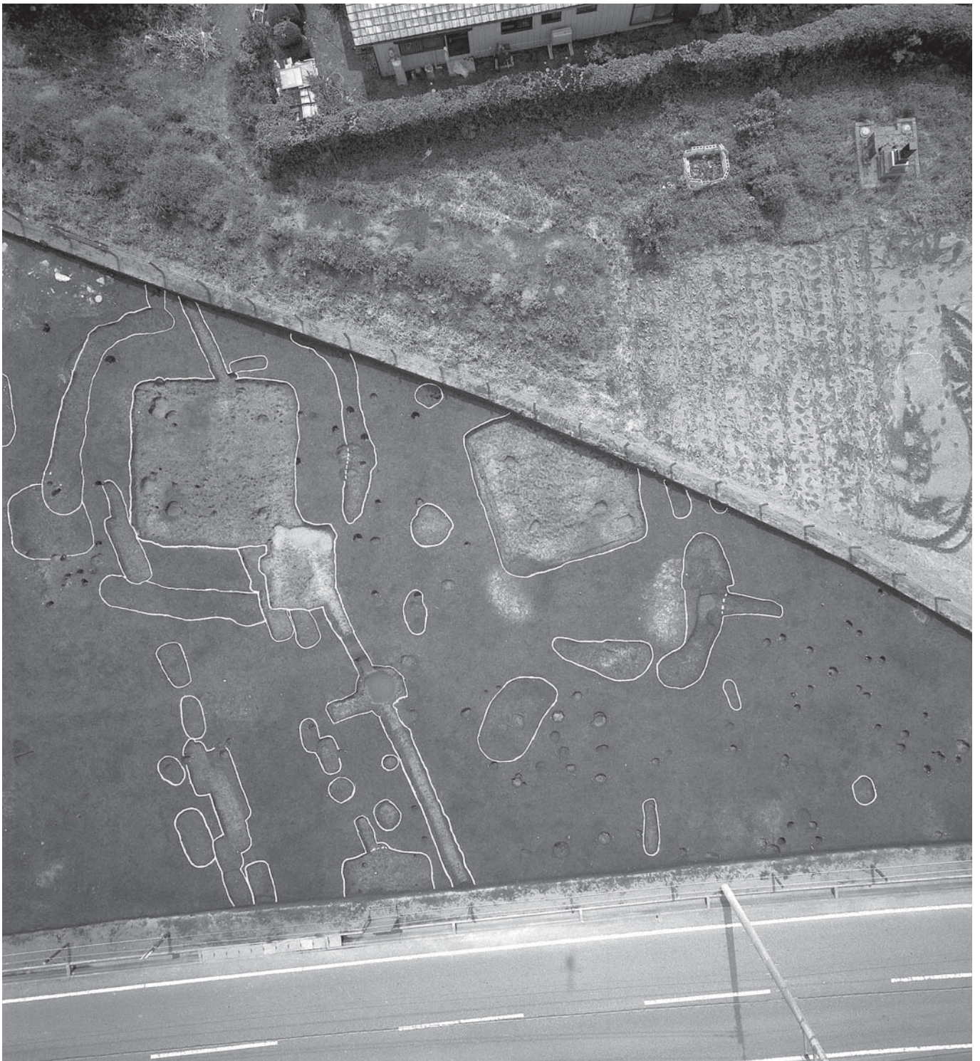
3区1～3号住居空中写真(北から)
