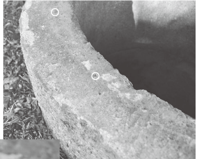
2 井戸側上面（部分） 近代以降、石製井戸側の上部にコンクリート製枠が設置される（現在撤去） コンクリート製枠を固定するための角釘及びその痕跡を約10箇所、その外部に枠当たり痕を確認
