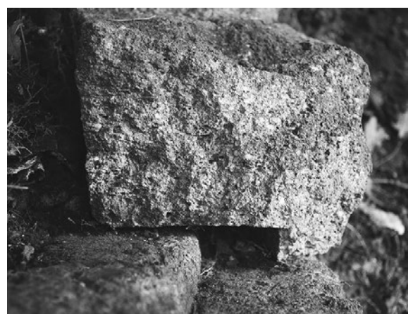
7 ④上・下段の組み合わせ加工 削り込んで、内・外部に段を作り出す ③も同様の加工
