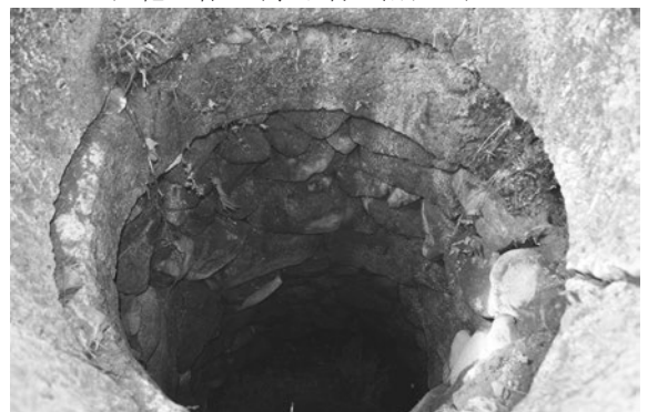
8 井戸跡内部 上2段は削り貫き材、下部は石組
