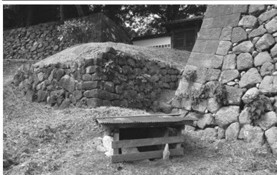
6 井戸跡の現況 奥は水ノ手門
