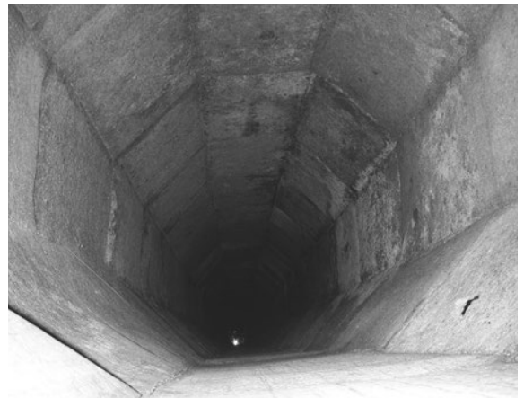
4 井戸跡内部 板石を組み合わせ、複数段積み上げ
