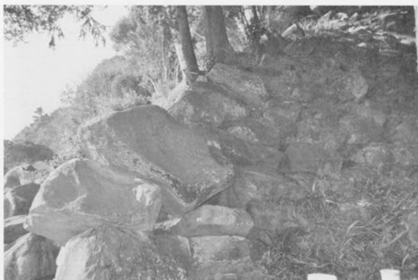
南曲輪隅角部
